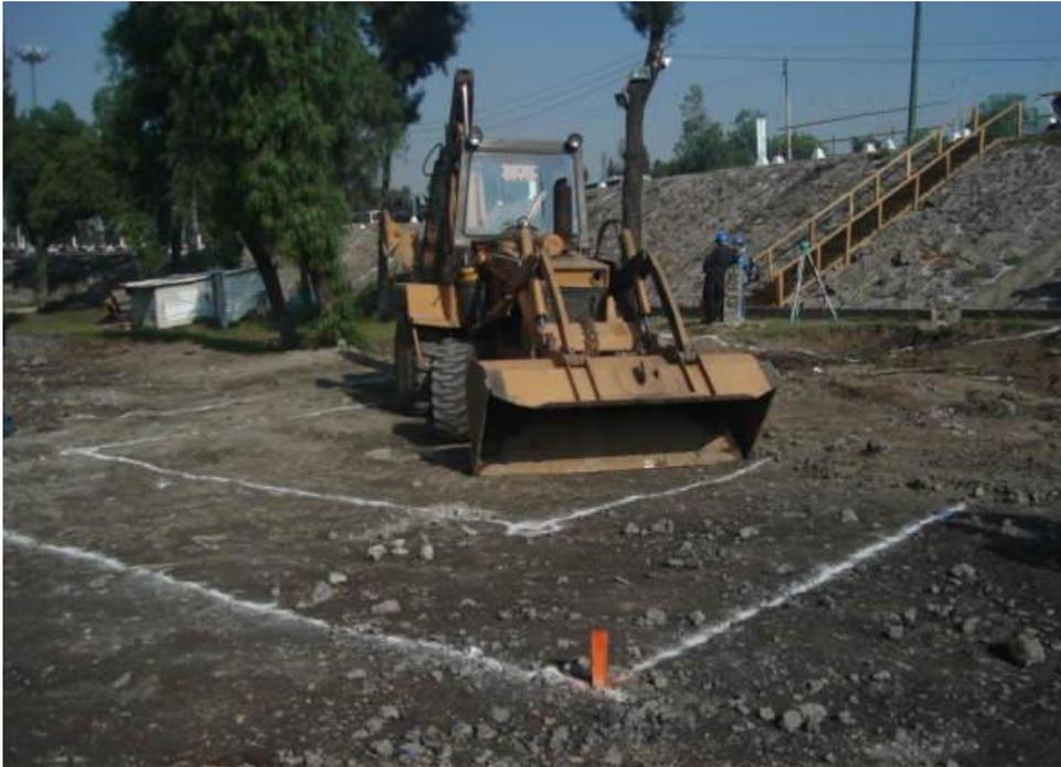
Trazo de perimetral de zapata y sobreexcavación
