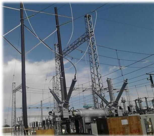
Figura 5.25.- Montaje de buses.
