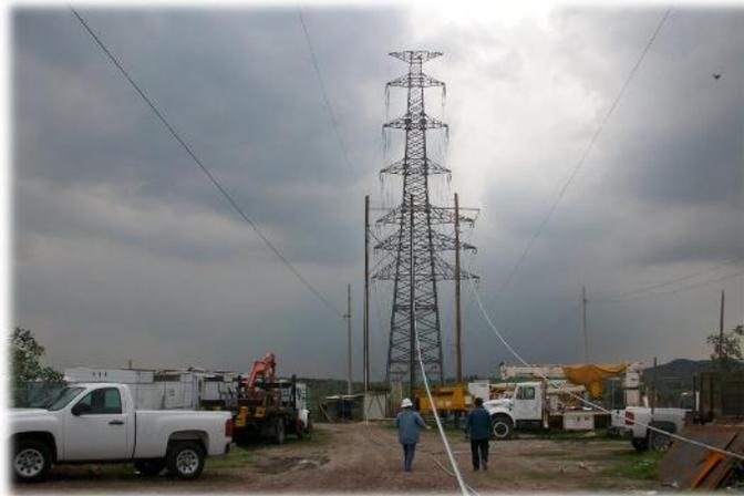
Figura 5.11.- Tendido y tensado de cable.
