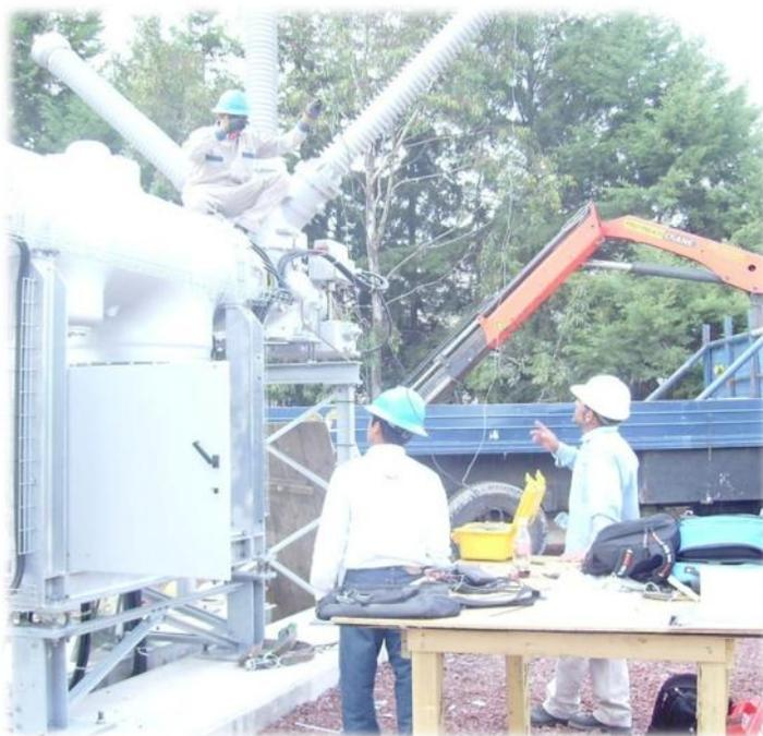
Figura 5.33.- Pruebas Preoperativas - Transformadores de corriente.
