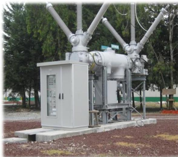
Figura 6.35.- Alimentador provisional para la S.E. Huehuetoca en 85 kV en operación.
