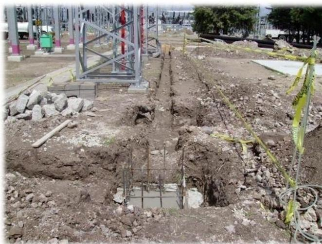
Figura 5.19.- Ductos eléctricos.
