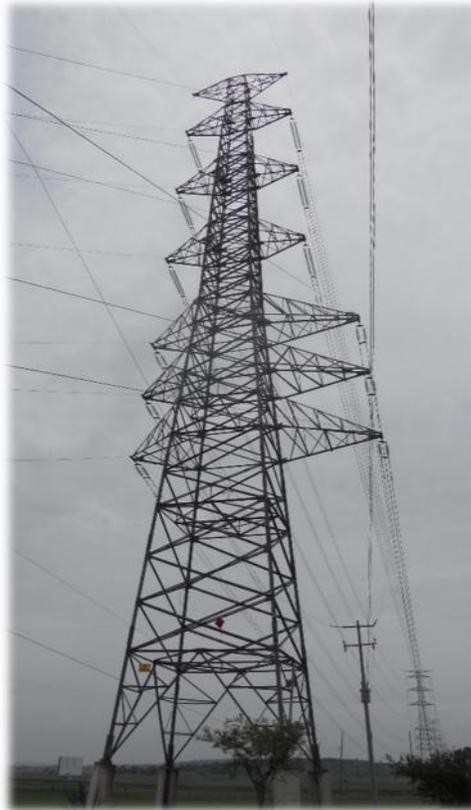
Figura 5.2.- Estructura normalizada 4 circuitos LyFC.
