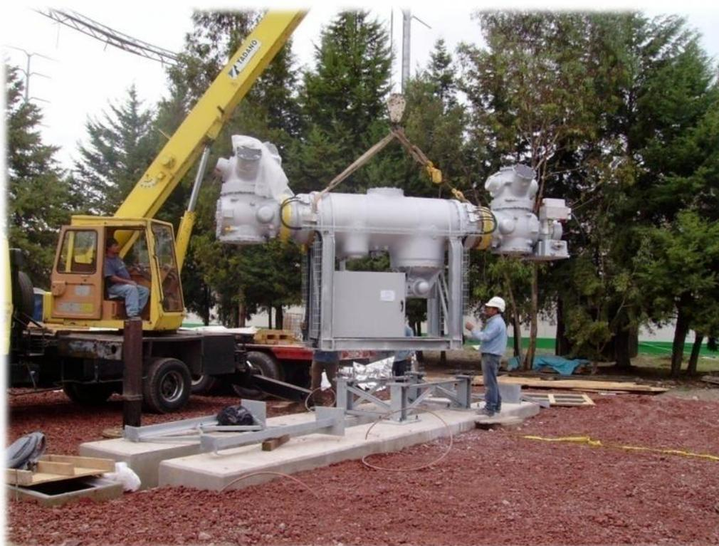
Figura 5.22.- Montaje de Módulo Híbrido de 85 kV
