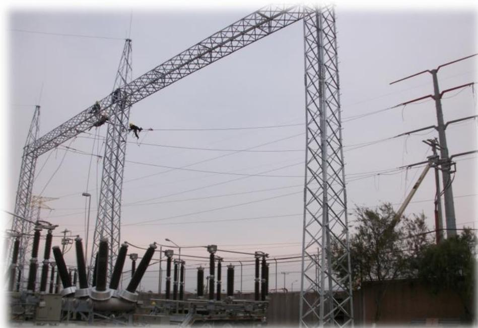
*Figura 4.5.- Apertura de L.T. Aurora - Chapingo de 230 kV
