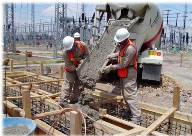
Figura 5.17.- Colocación de Concreto.
