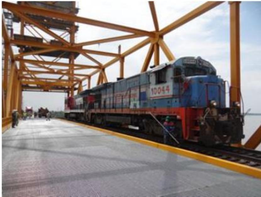
*Figura 4.27 Prueba de carga estática E5 [13]*
