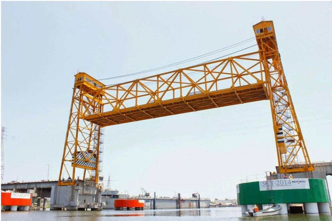
*Figura 2.1 Tramo de armadura del puente Coatzacoalcos I*
