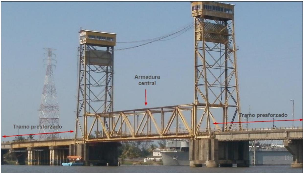
**Figura 3.7 Estructura general del puente Coatzacoalcos I [22]**
