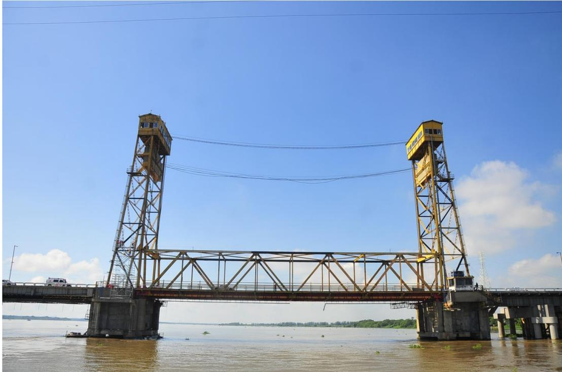
**Figura 3.10 Sistema de torres para elevado de armadura**
