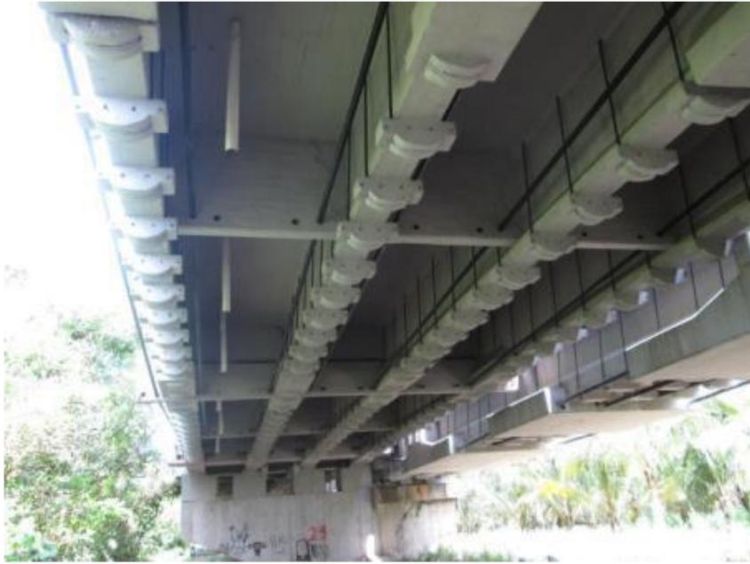
*Figura 3.3 Refuerzo colocado en vigas [20]*
