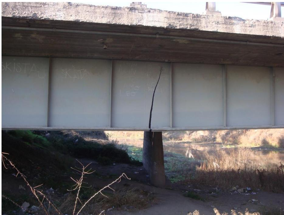
**Figura 1.1** Ejemplo de fractura en un elemento debido a fatiga [web]
