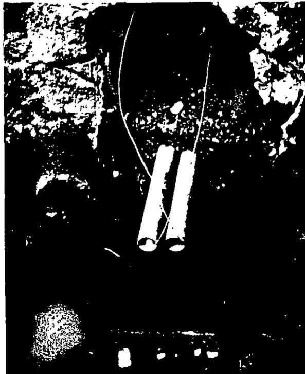
**ÉSTA FOTOGRAFÍA MUESTRA LA INSTALACIÓN DE LAS TUBERÍAS DE FIERRO GALVANIZADO DE 2" DE DIÁMETRO Y SU ENCOFRADO, MISMOS QUE SERVIRÁN EN LA REUBICACIÓN DE FIBRA ÓPTICA.**
