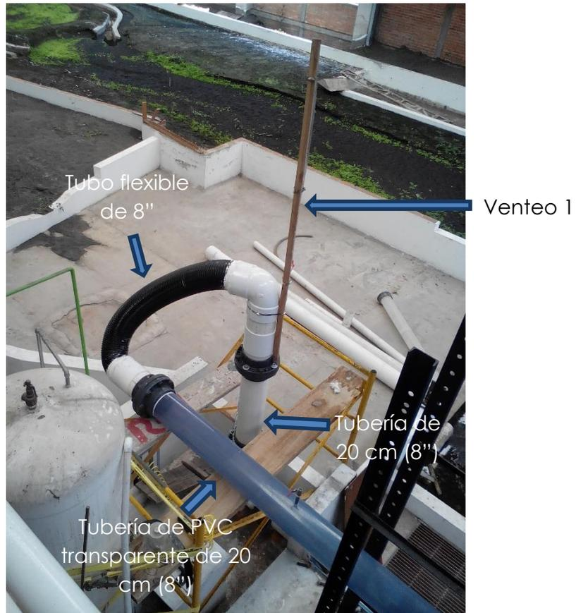
Figura 4. 6. Tramo de ampliación en línea de conducción
