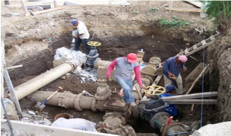
Figura 1. 29. Cruce de tubería de agua potable
