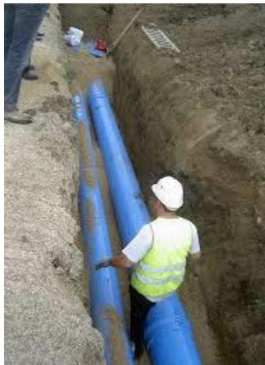
Figura 1. 9. Tendido de tubería de PVC
