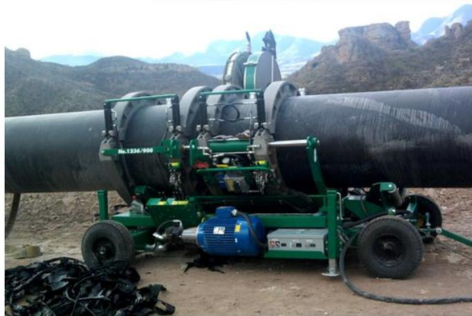
Figura 1. 11. Unión por Termo-fusión en tuberías de PEAD
