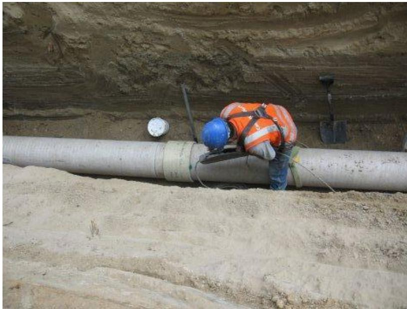
Figura 1. 13. Tendido de tuberías de PRFV
