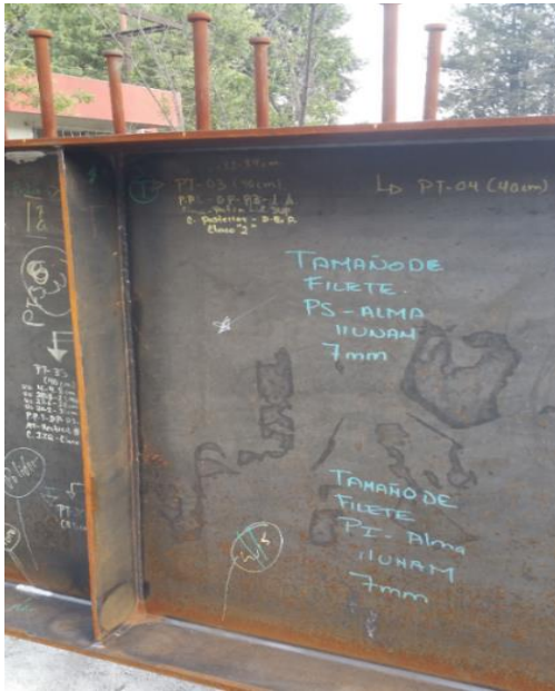
Fotografía N.- 4 Tamaño del filete dovela metálica
