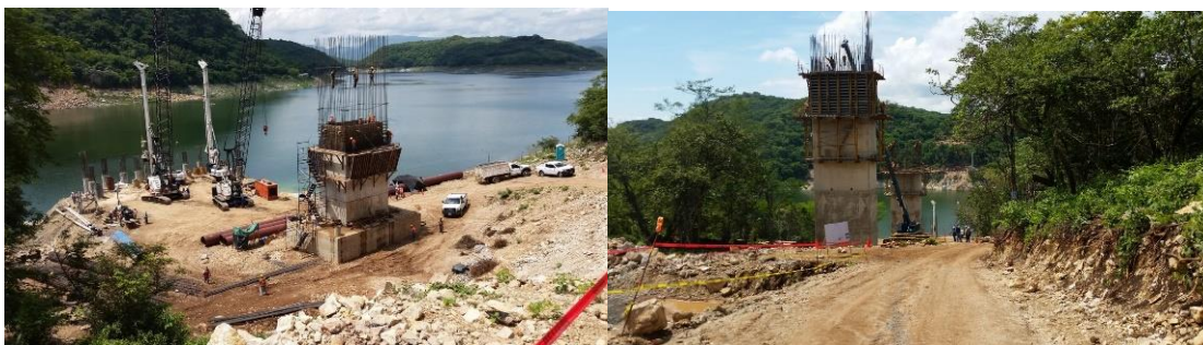
Fotografía N.- 2 Armado de Pilas puente Concordia 2016
