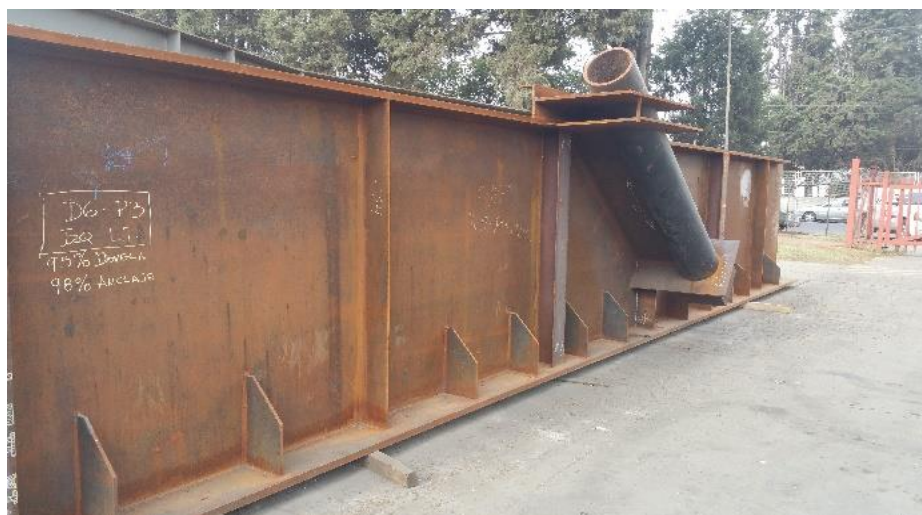
Fotografía N.- 1 Dovela metálica
