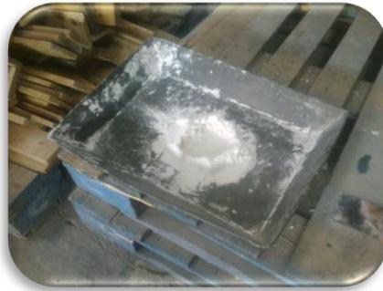
7.- Se hace la mezcla con las cuñas de acero aproximadamente de dos a tres minutos, tratando de que sea lo más rápidamente ya que es de secado rápido, el batido se realiza de manera que se quiten todos los grumos o bolitas secas de cemento, hasta dejarlo uniformemente.
