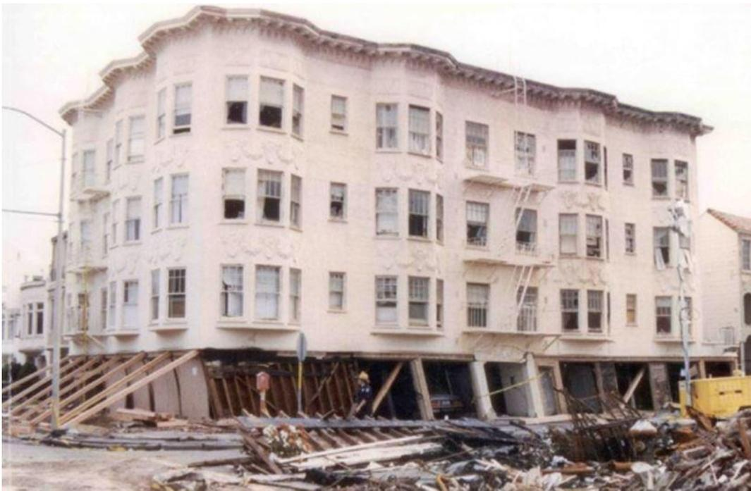
*Fig. 5 Estructura con piso suave dañada durante sismo (Aditi H. & Vipin V., 2015).*
