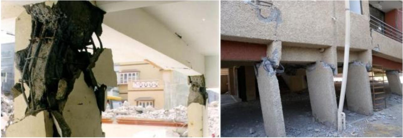
*Fig. 6 Fallas en columnas de estructuras con piso suave (Aditi H. & Vipin V., 2015).*
