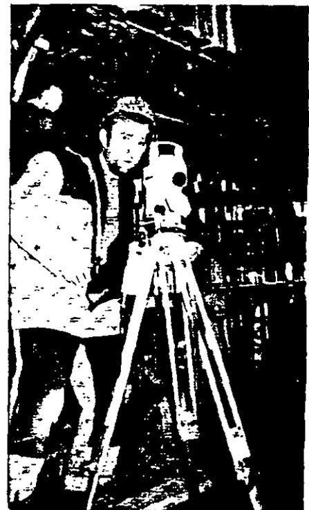
Derecha: La Estación Total LEICA TC1600 es utilizada para los trabajos de control durante la construcción de la plataforma de gas Troll en Vats, Noruega, de 470 metros de altura total.
