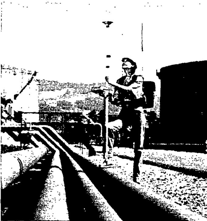
**El empleo de un par de receptores GPS (de precisión) operando en modo estático, dinámico o en tiempo real y de la Estación Total, es la combinación perfecta para efectuar prácticamente cualquier tipo de levantamiento topográfico, en condiciones de gran eficiencia, seguridad de la información y pronta respuesta a los requerimientos del proyecto, independientemente de su magnitud, posición geográfica, topografía del lugar, vegetación, condiciones atmosféricas, etc.**
