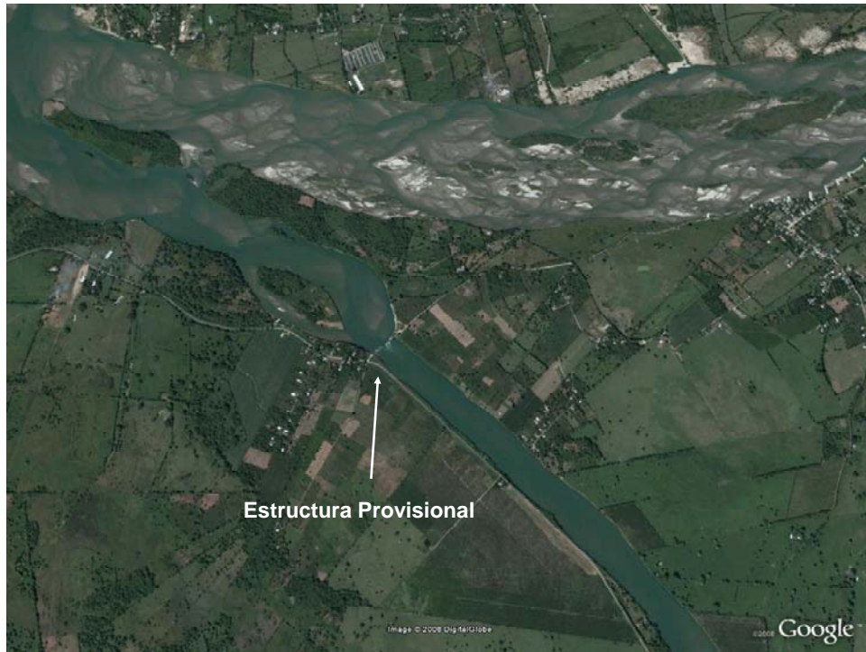
Figura 1.3 Vista de la bifurcación y de la localización de la Estructura Provisional
