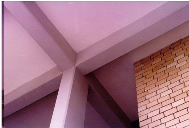
Figura IV.1.2 Losas macizas en dos direcciones.
