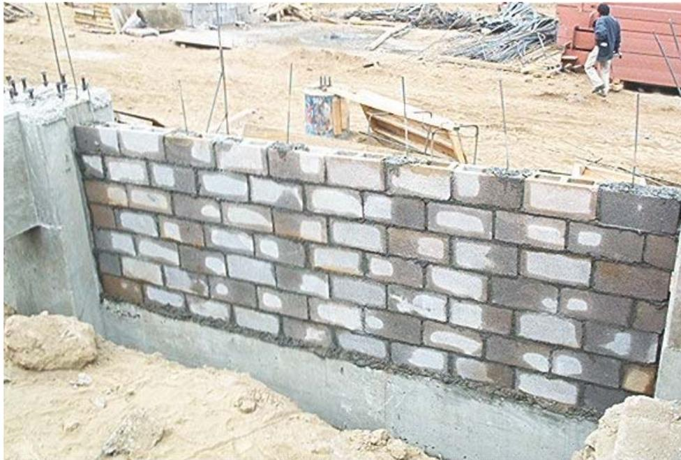
Refuerzo de acero en muro de tabique.
