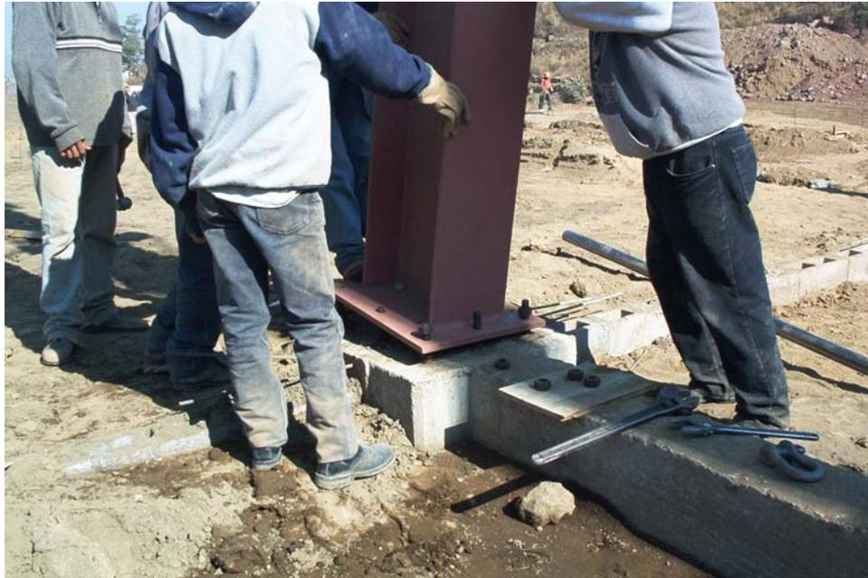
Rápida colocación de una columna prefabricada de acero, que da como consecuencia, el ahorro de tiempo en endurecer y sostenerse por si misma, así como el ahorro en dinero de la cimbra, si fuera de concreto reforzado.
