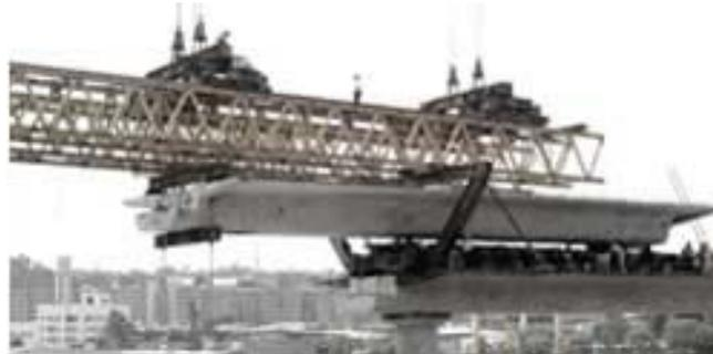
Durante la colocación de los elementos prefabricados, se presentan problemas como la renta de maquinaria (grúas, gatos hidráulicos, etc), además de que se debe tener el espacio adecuado para las maniobras de estas maquinas.
