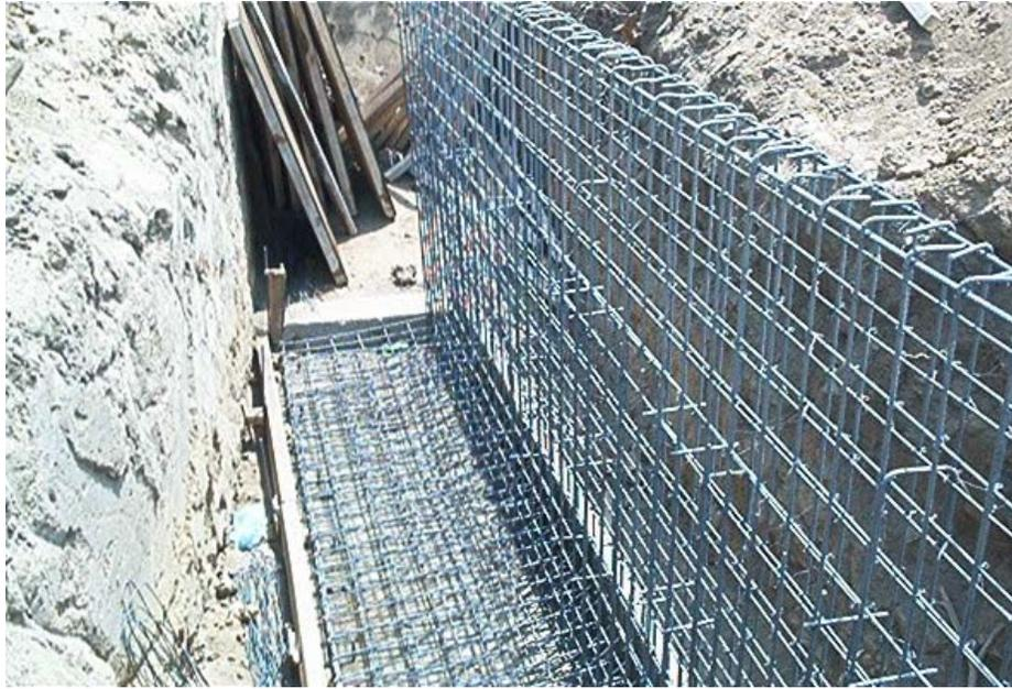
IV.5.2 Detalle de acero de refuerzo en una zapata corrida.
