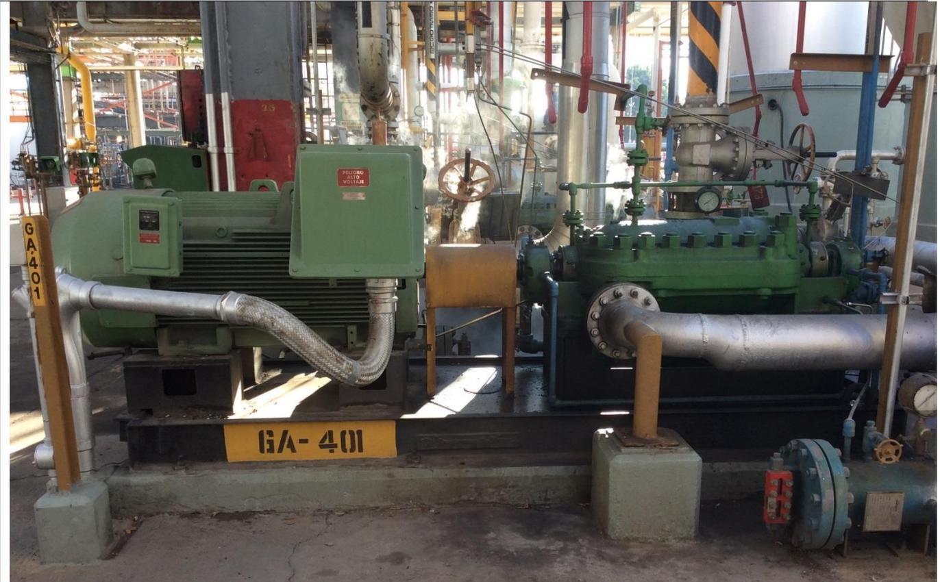
Vista del equipo GA-401, donde se aprecia el conjunto bomba - motor.
