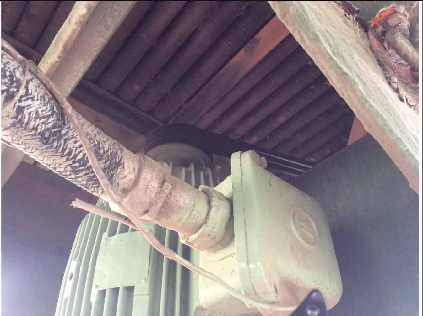
Detalle del acoplamiento por poleas y bandas trapezoidales en el motor eléctrico de inducción.
