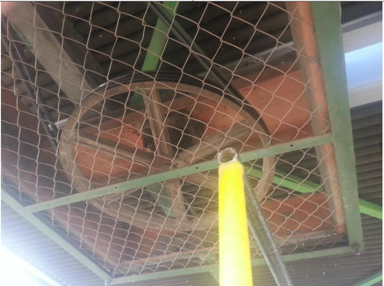
Vista de la polea y bandas trapecoidales en la chumacera inferior del ventilador axial.
