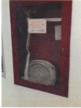
Fig. 1.7 Hidrante tipo empotrar. Fuente: Fotografía tomada por el autor
