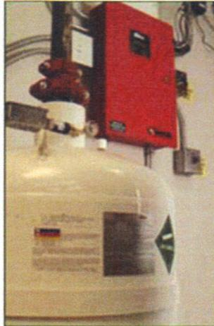
Fig. 1 2 Cilindro contenedor de agente limpio (ecaro 25 o FM 200) y tablero de control para el sistema de detección y supresión. Fuente: DSI México.
