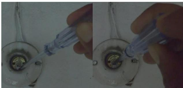
Imagen 131. Apagador de foco conectado correctamente. Izquierda: casquillo; derecha: contacto central.
