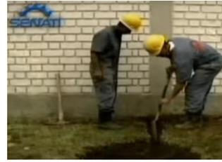
Imagen 106. Excavación de la zanja.
