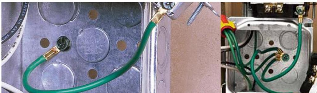
**Imagen 71. Conexión de la caja metálica al conductor de puesta a tierra**
