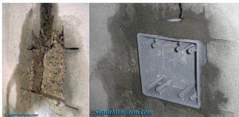
**Imagen 74. Colocación de caja plástica en tabique (Fuente: [sugarmtnfarm.com](http://sugarmtnfarm.com))**
