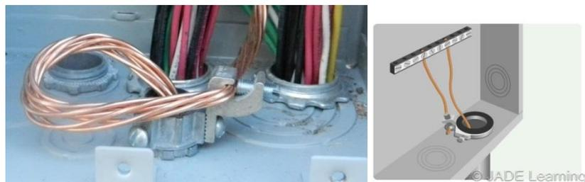
**Imagen 103. Puente con el conduit metálico.**
