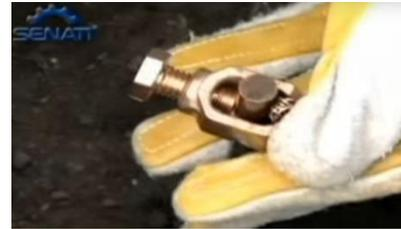
Imagen 108. Conexión del electrodo y su respectivo conductor.
