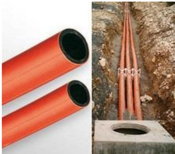
Imagen 42. Tubo Conduit de polietileno de alta densidad tipo HDPE. Obtenido de: [http://pvcdemonterrey.com.mx/?page\\_id=5](http://pvcdemonterrey.com.mx/?page_id=5) el 29/07/2015
