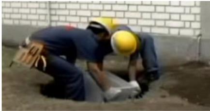
Imagen 107. Colocación de registro prefabricado.
