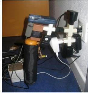
Imagen 55. Sobrecarga originada por demasiadas cargas sobre un circuito.
