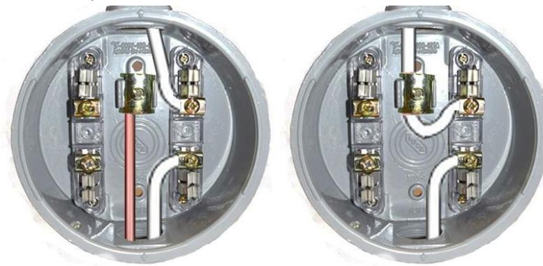
Imagen 101. Conexiones posibles en el medidor cuando el puente principal está en el interruptor principal.
