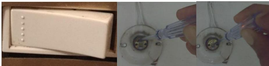
Imagen 132. Terminales del portalámparas conectado correctamente.
