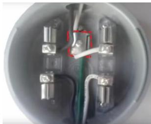
Imagen 100. Puente de unión principal en el medidor
