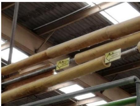
**Ilustración 23** Aislante de tuberías ineficiente
