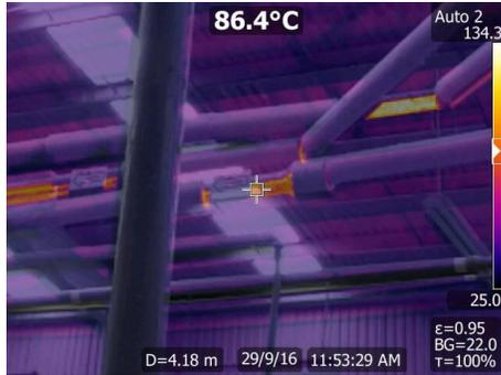
**Ilustración 26** Partes de la tubería sin aislante
