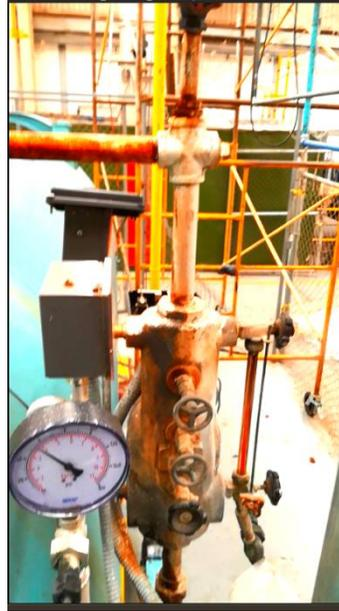
Ilustración 27 Desgaste en las Válvulas
