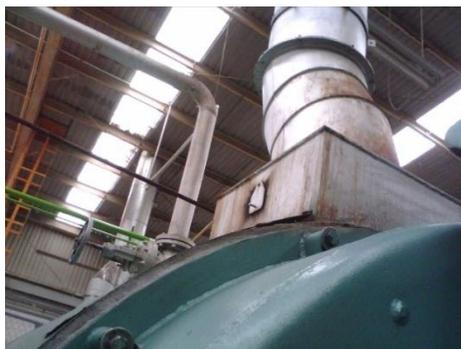
Ilustración 16 Chimenea de gases de combustión
