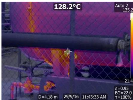
**Ilustración 20 Aumento de temperatura en los soportes**
