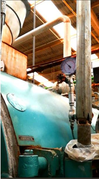
Ilustración 28 Fugas de vapor
