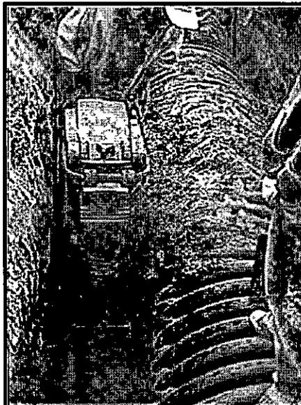
FIGURA 21. COMPACTACIÓN DE ZANJAS.
