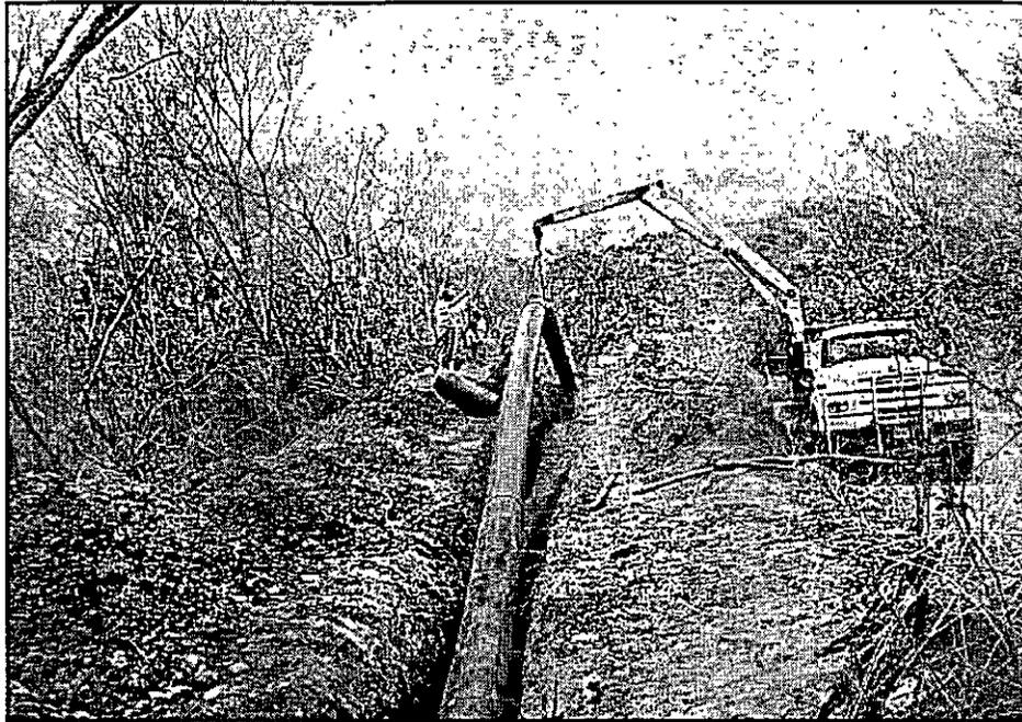
FIGURA 13. COLOCACIÓN DE LA TUBERÍA EN LA ZANJA.
