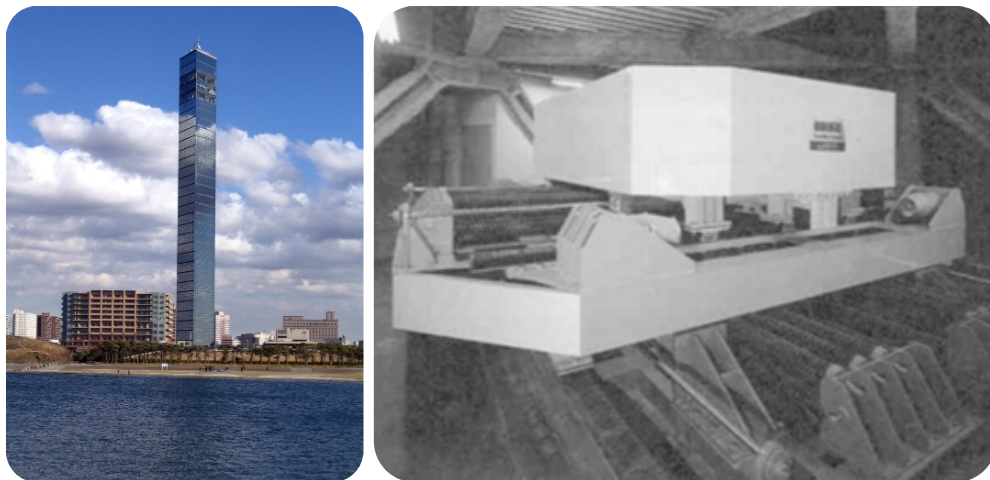
Figura 10. Rascacielos Chiba-Port y su dispositivo disipador MSS. Connor, 2002 y https://goo.gl/67ympV .
