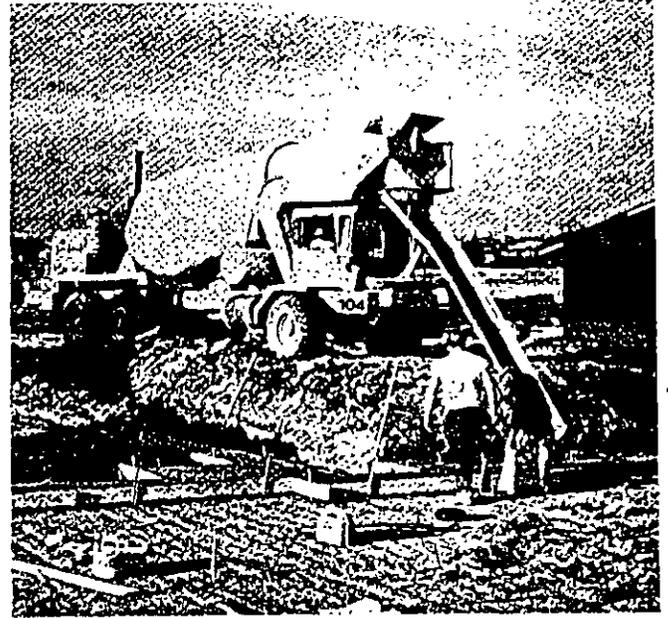
En comparación con los camiones convencionales de descarga trasera, los camiones mezcladores de descarga frontal le proporcionan al conductor una mayor movilidad y control en la descarga directa del concreto en las cimbras.
