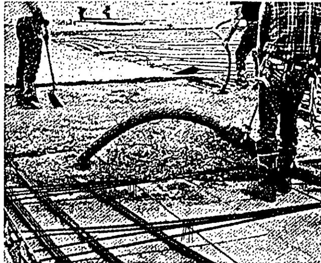
Vista de una manguera flexible descargando concreto conectada a la tubería rígida que deriva de la bomba. La tubería rígida se emplea para la conducción de concreto bombeado en las plumas y sin necesidad de estructuras especiales a través de distancias relativamente largas. Hasta 7.5 m de manguera flexible se conectan para aumentar la movilidad durante el colado.
