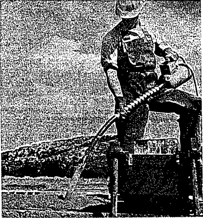
Los vibradores internos se utilizan comúnmente para consolidar al concreto en muros, columnas, vigas y losas.
