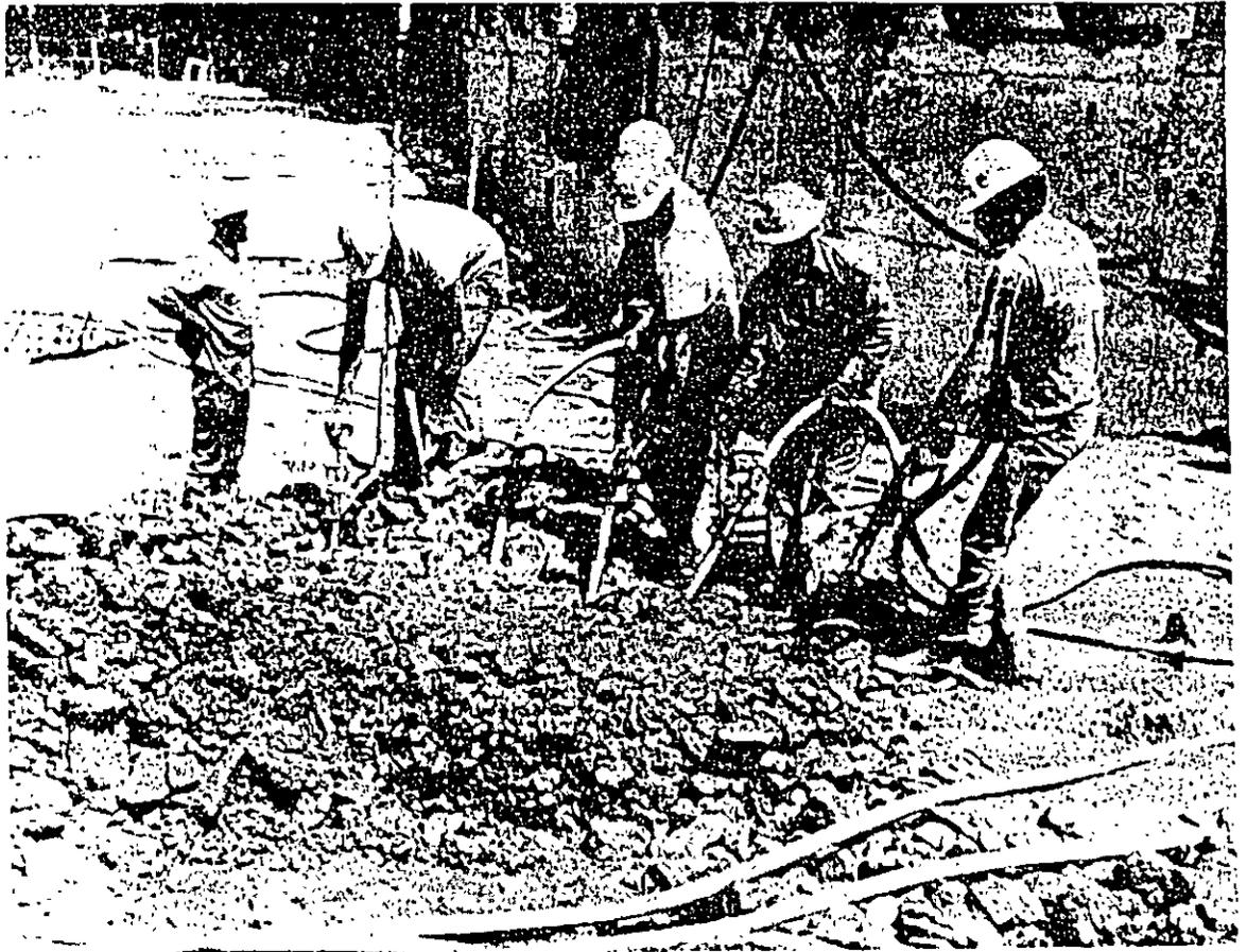
Vibración sistemática de la capa de concreto.
