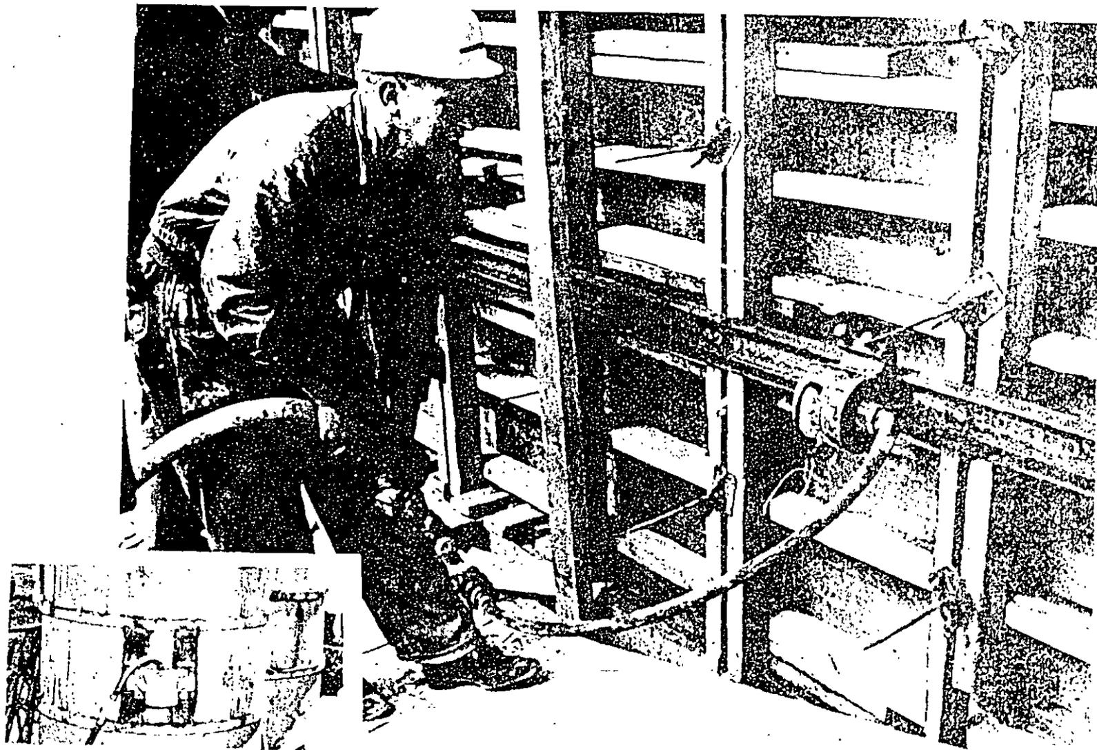
Montaje de vibradores; en cimbra de madera para muros y en cimbra para tubos (Inserto).
