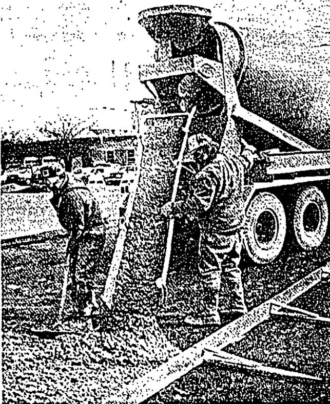
Por medio de la descarga directa desde el canalón del camión mezclador, frecuentemente se puede colocar en su sitio final al concreto premezclado.
