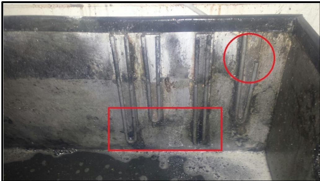
Figura 4.32 Guía fracturada y moho acumulado
