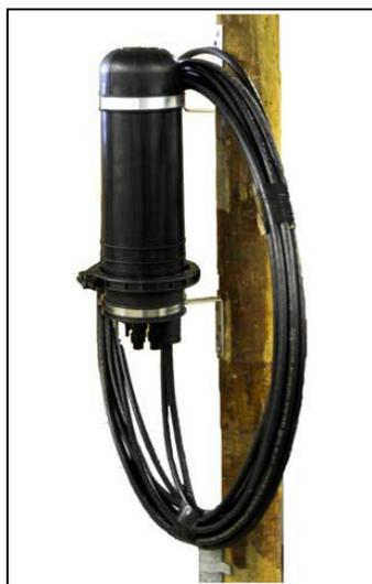
**Figura 5.** Cierre vertical montado en poste.
