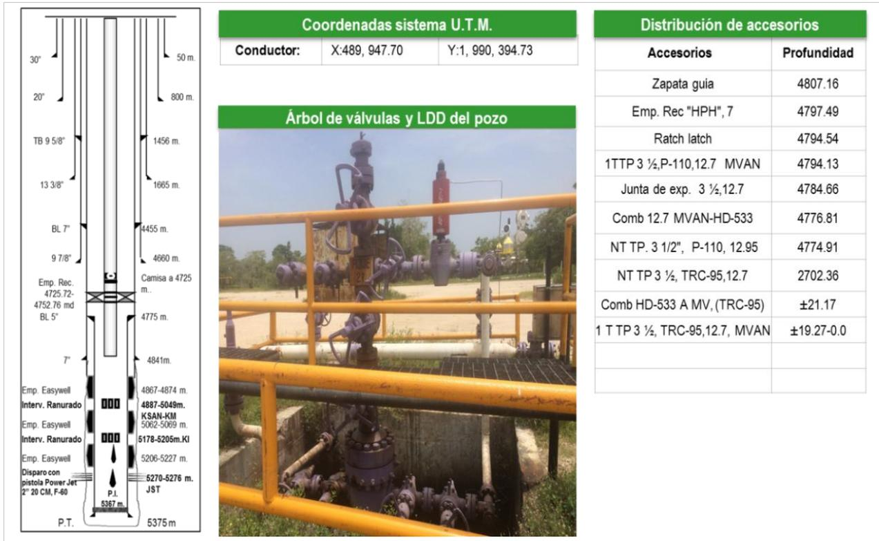
Figura 3.15 Ficha técnica – Estado mecánico, árbol de válvulas y LDD del pozo
