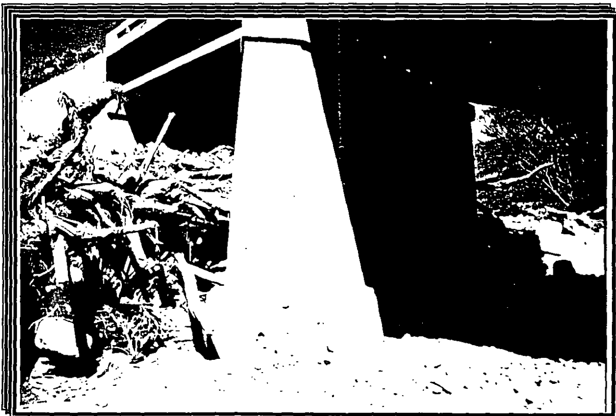
FOTO No. 4 Obsérvese la magnitud de los cuerpos flotantes, aspecto que debe considerarse en un estudio topohidráulico.
