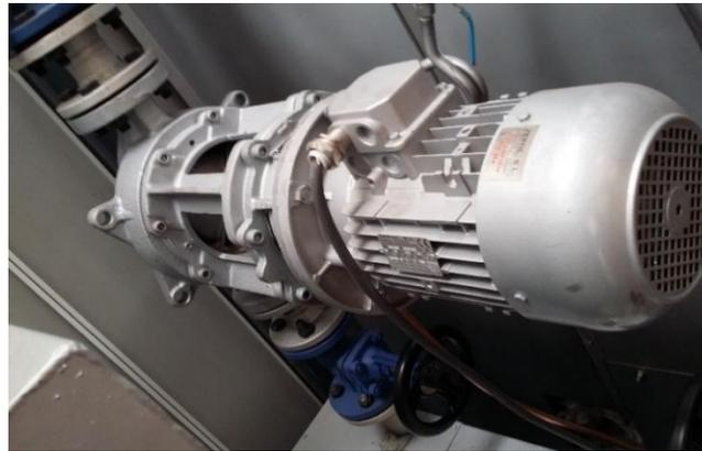
Imagen 14. Conjunto Motor-Cuerpo Bomba modelo ALLWAILER
