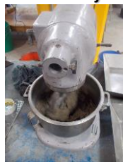
Fig. 7.11 Mezclado de cemento, arena y agua.
