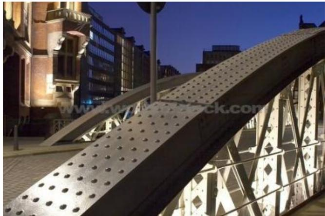
**FIGURA 10.42** La aplicación de las uniones mediante remaches es muy variada, ya que lo mismo se utiliza en el ensamble de la estructura de armas de fuego que en elementos estructurales
