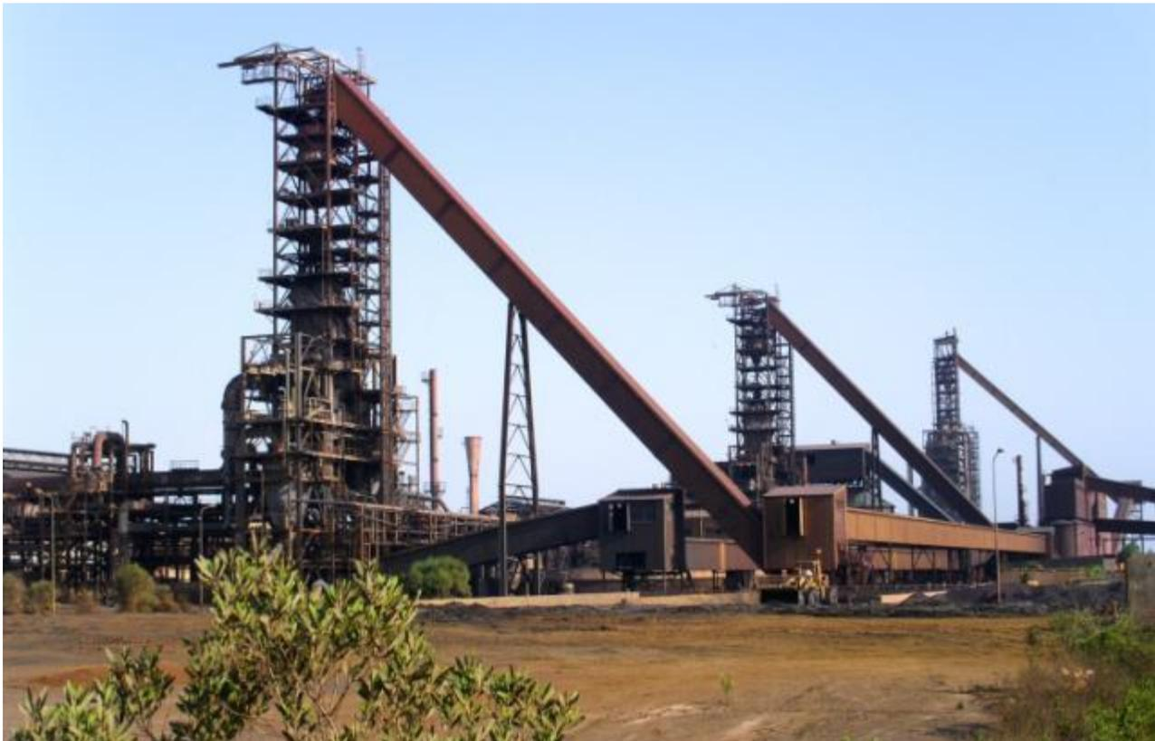
**FIGURA 2.23** Planta con tres reactores de reducción directa [Libyan Iron and Steel Complex, Misratah]
