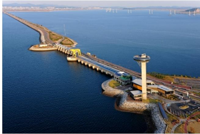
Figura 2.10: Planta mareomotriz Sihwa Lake, 254 MW (flujo y reflujos).
