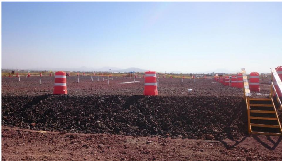
Figura II.5 Terraplén de la prueba de vacío con membrana. Foto por el autor.
