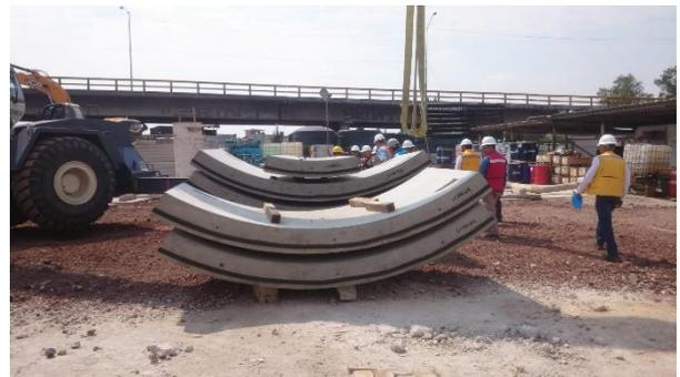
Figura IV.8 Dovelas para los anillos del túnel Churubusco - Xochiaca
