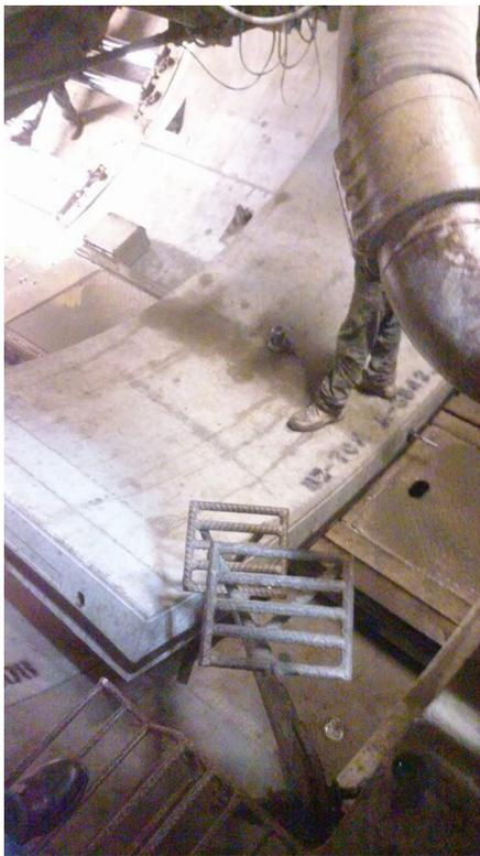
Figura IV.7 Colocación de las dovelas del túnel Churubusco - Xochiaca. Elaborado por el autor
