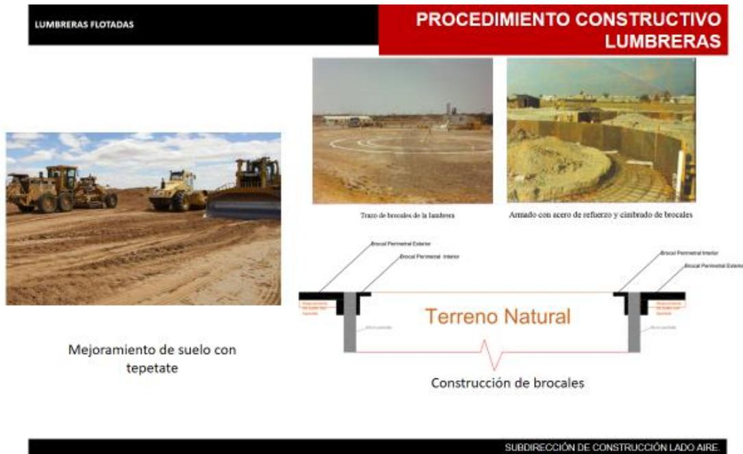
Figura II.9 Presentación del procedimiento constructivo de las lumbreras. Realizado por el mismo autor con imágenes de la tesis de Guadalupe Jiménez Sevilla "Procedimiento constructivo de lumbreras por el método de flotación". [file:///C:/Users/Veron/Downloads/370\\_PROCEDIMEINTO%20CONSTRUCTIVO%20DE%20LUMBRERAS%20POR%20EL%20METODO%20DE%20FLOTACION.pdf](file:///C:/Users/Veron/Downloads/370_PROCEDIMEINTO%20CONSTRUCTIVO%20DE%20LUMBRERAS%20POR%20EL%20METODO%20DE%20FLOTACION.pdf)
