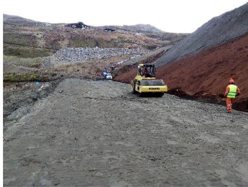
Figura 5.9: Trabajos de compactación en arenas de relave con rodillo liso vibratorio (Nyrstar, 2017).
