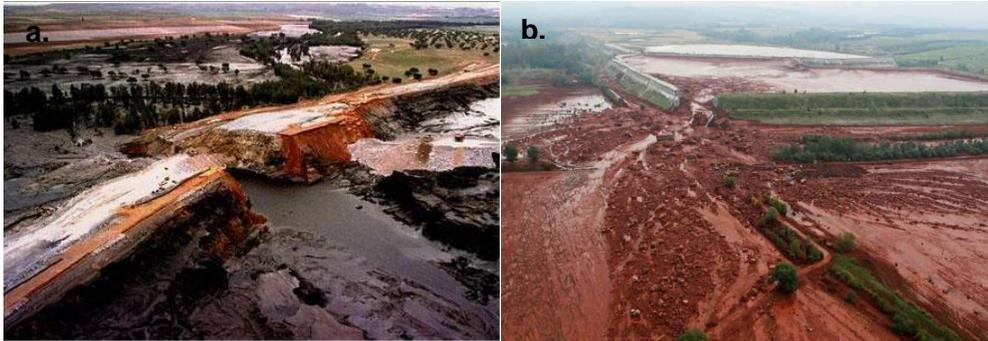
Figura 6.6: Rotura de diques de los depósitos de relaves en a) Aznalcóllar en España en el año 1998 y b) Kolontar en Hungría en el año 2010 (Fajardo y Fuentes, 2014).
