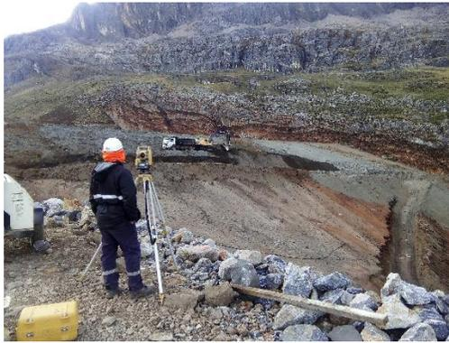
Figura 7.1: Monitoreo de desplazamiento con equipo topográfico (Nyrstar, 2017).
