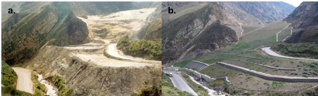
Figura 6.8: Depósito de relaves Tablachaca en Perú, a) antes de la remediación y b) después de estabilización de taludes y colocación de cobertura vegetal (Cacciuttolo y Tabra, 2015).
