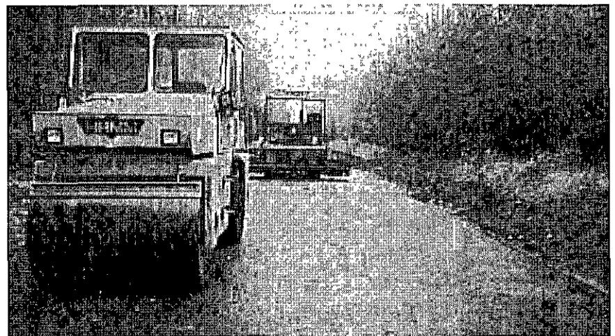
Colocación del pavimento asfáltico con extendidora Vögele sobre la capa reciclada.
