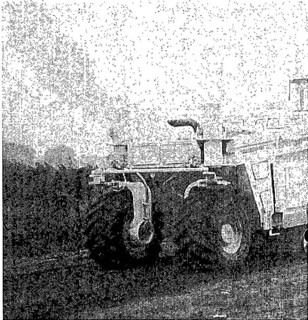
El reciclador WR 2500 empujó el camión cisterna durante las operaciones de fresado y mezclado de
