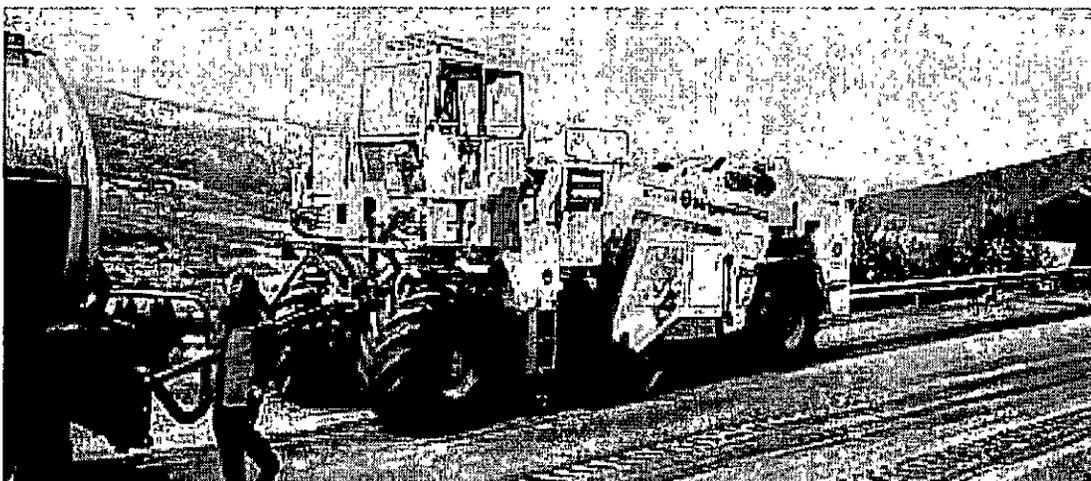
Rehabilitación de una carretera en Noruega: la recicladora WR 2500 está acoplada al carrotanque independiente y el betún caliente se espuma en la recicladora y se incorpora uniformemente.
