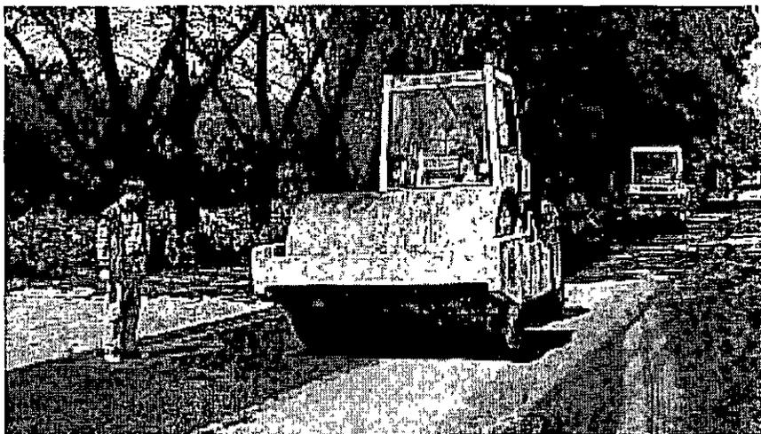
Compactación de la capa reciclada de 20 cm de espesor con equipo monocilíndrico pesado y rodillo vibrante tándem.
