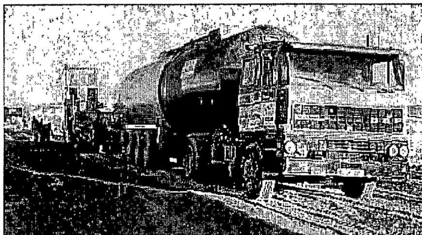
Reciclado del tercer carril con cemento, sin interrupción del tráfico.
