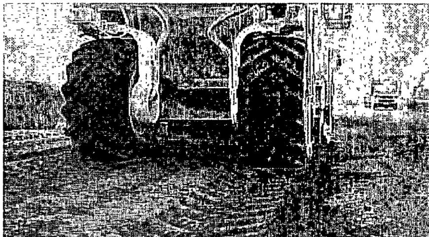
Mezcla homogénea de los materiales con proceso óptimo de humectación para la compactación.
