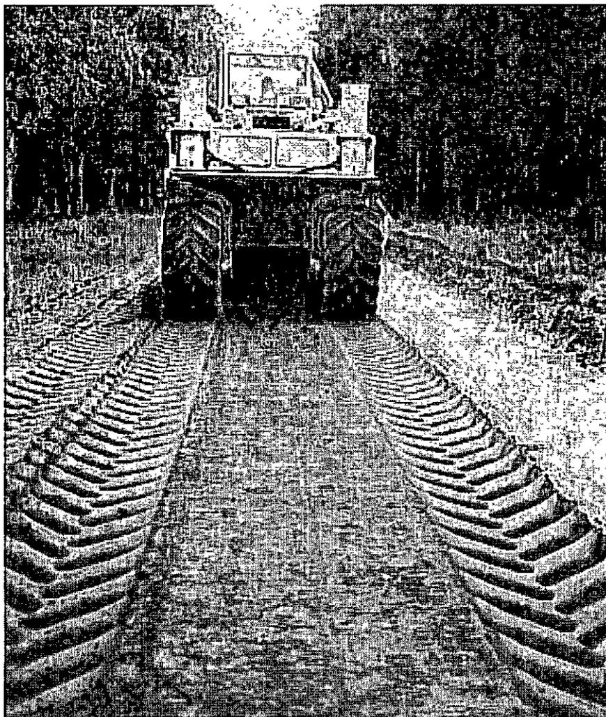
Ejecución del proceso constructivo de reciclado de la base portante sin juntas, en tramos de 3 secciones paralelas.
