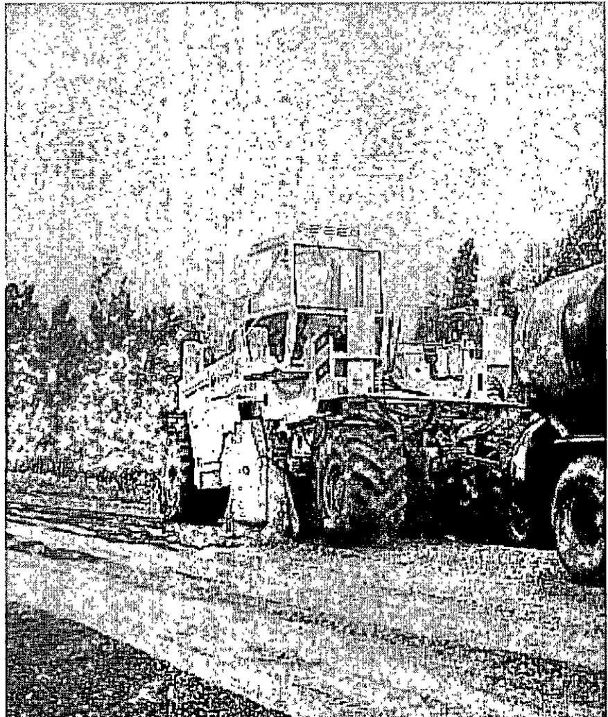
Después del proceso de granulación con la máquina 2100 DCR, los materiales existentes fueron mezclados y reciclados por la máquina WR 2500 con betún destilado de pizarra.
