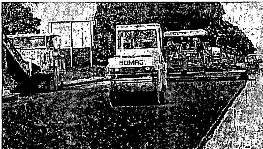
Colocación de la capa asfáltica de base a lo ancho de dos carriles y compactación con rodillo vibrante tándem.
