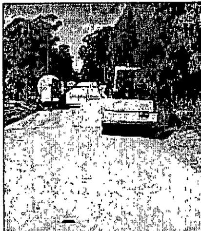
El firme saneado, después de la compactación final con rodillo monocilíndrico liso.
