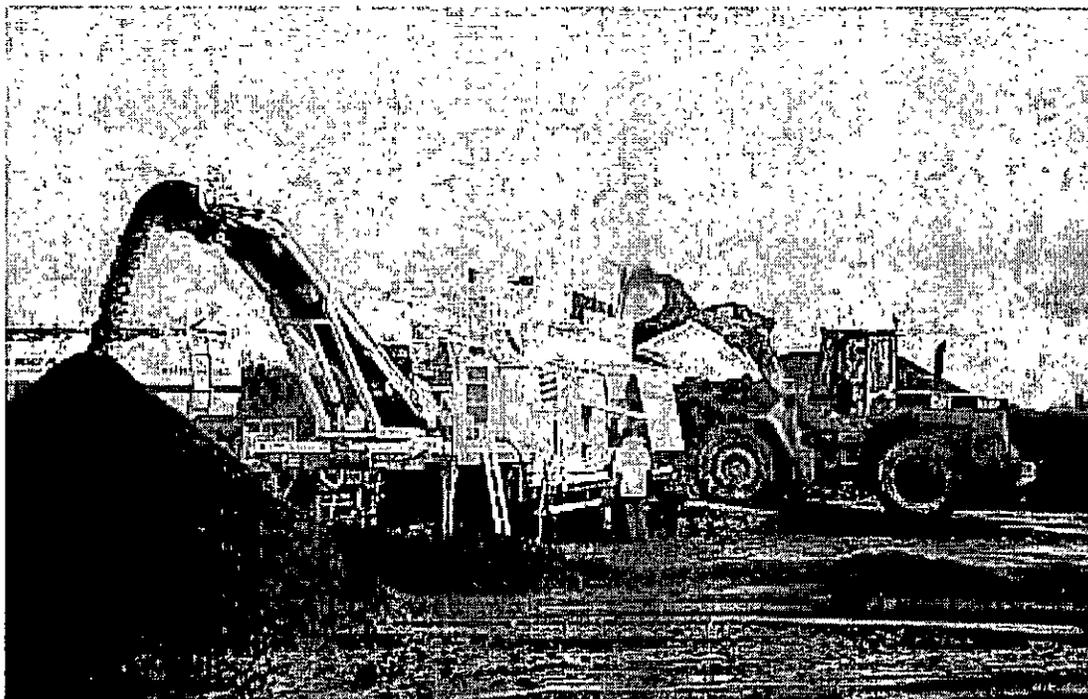
Producción para el almacenamiento en un vaciadero del material fresado y mezclado con betún espumado: mediante telemando es posible arrancar y parar la producción con la máquina KMA 150 desde la cargadora sobre ruedas.
