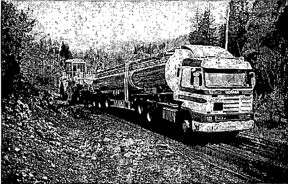
Una prueba del rendimiento de la máquina WR 2500: en esta obra en Noruega, el abastecimiento de ligante de este carrotanque fue suficiente para reciclar 2.500 m<sup>2</sup> en poco menos de 2 horas.
