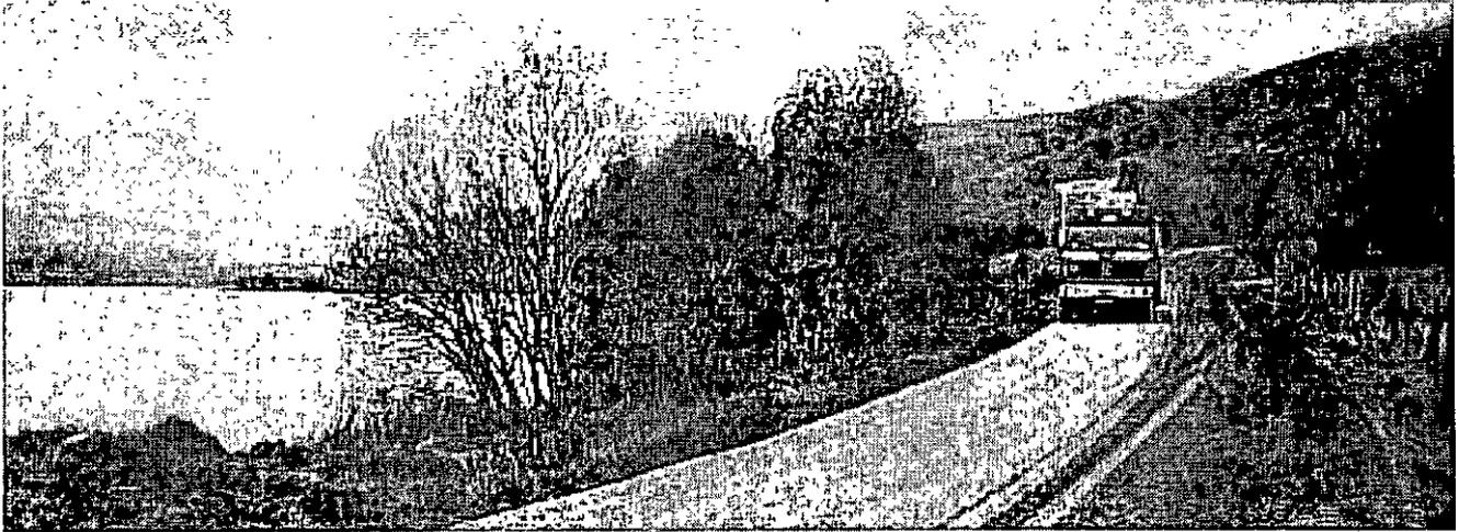
Ejemplo de rendimiento máximo en obras de reciclado con espuma de betón: Saneamiento de tramos de carreteras de 1,5 km de longitud y tres carriles paralelos.
