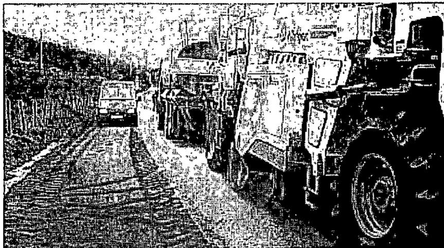
En esta vía de baja intensidad de tráfico en Noruega se permite el paso lento de vehículos sobre la capa reciclada antes de la compactación.
