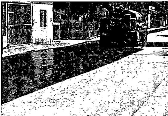
Se sugiere su aplicación como alternativa económica, para impermeabilizar la base estabilizada y así protegerla del desgaste proporcionando una superficie antiderrapante.
