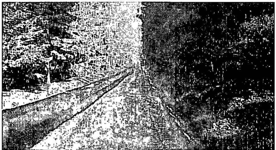
La obra de reciclado: a la derecha el firme existente con granulado asfáltico aportado; a la izquierda el carril de la capa de materiales tratados con el reciclador WR 2500.
