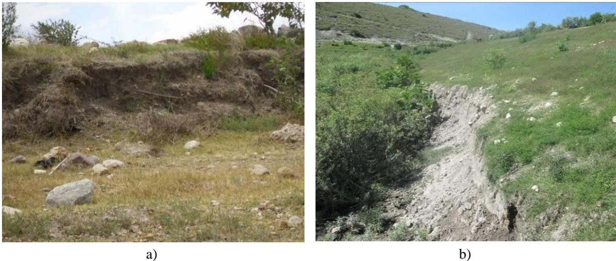
Figura 9.22. Socavación por oleaje en (a) la parte alta y (b) parte baja del talud aguas arriba de la presa.
