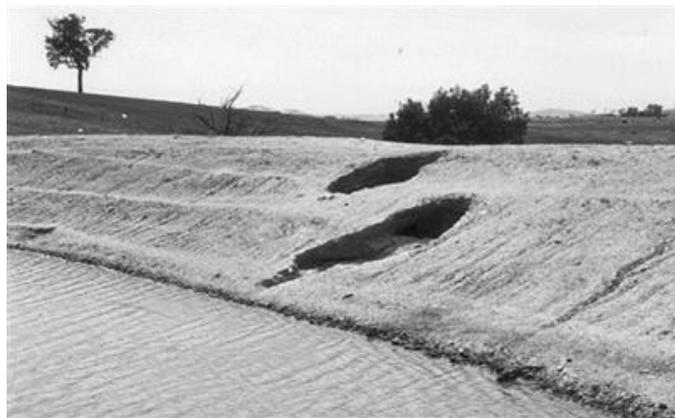
Figura 8.42. Tubificación en una presa construida con suelos dispersivos en NWS, Australia (Fell et al., 2015).
