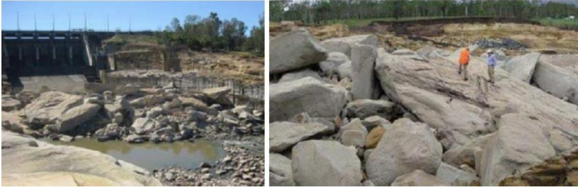
Figura 8.5. Presa Wivenhoe, Australia. Desprendimiento y arrastre de grandes bloques de roca del tanque de amortiguación labrado en el macizo rocoso de cimentación (Stratford et al., 2013).
