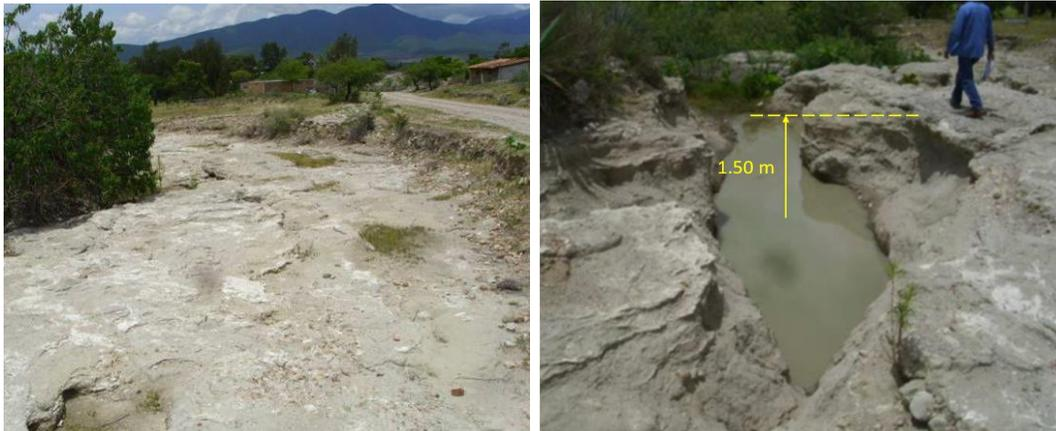
Figura 9.16. Socavación en el lecho del canal vertedor de la presa.
