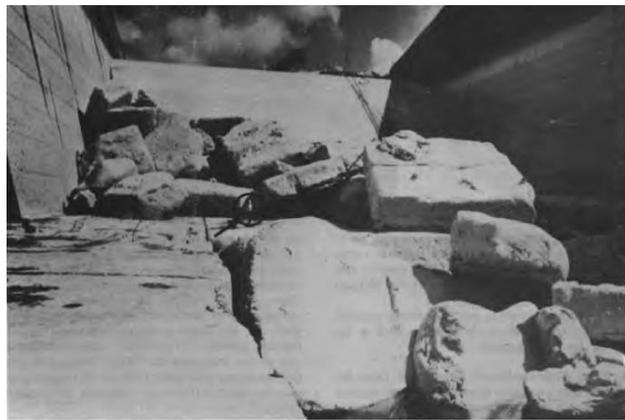
Figura 8.6. Presa Nezahualcóyotl (Malpaso), Chiapas, México. Losas del estanque amortiguador desplazadas hacia aguas abajo (Marsal y Reséndiz, 1975).
