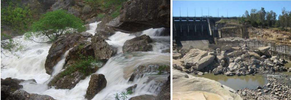
Figura 5.10. Socavación en lechos rocosos de ríos de montaña (alta pendiente) y en estanques amortiguadores de presas labrados directamente en el macizo rocoso. (Bollaert y Lesleighter, 2014)
