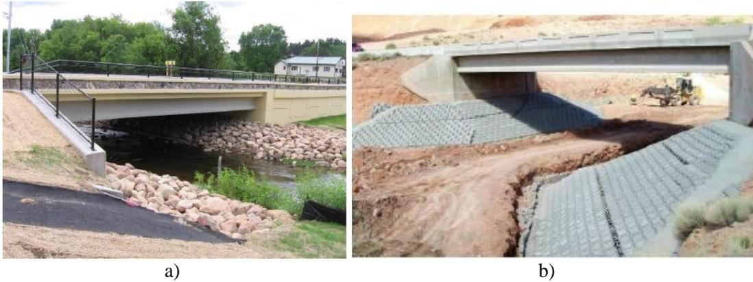
Figura 7.45. Protección de estribos en puentes mediante (IHRB, 2006): (a) enrocamiento y (b) pavimentos flexibles.
