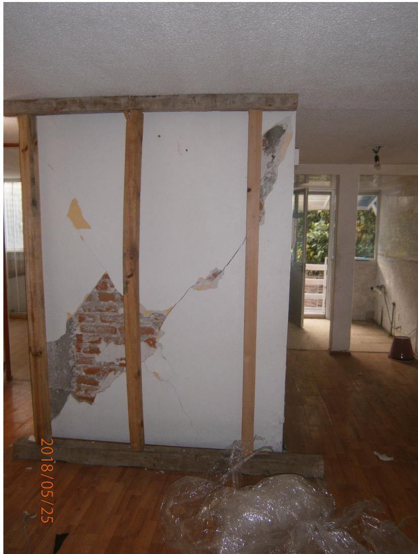
**Figura 2.18:** Daño en muro de mampostería, fisura diagonal por fuerza cortante.
