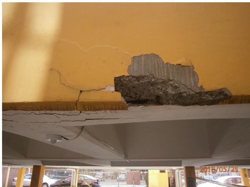
Figura 2.17: Daño en nervadura principal del sistema de piso.
