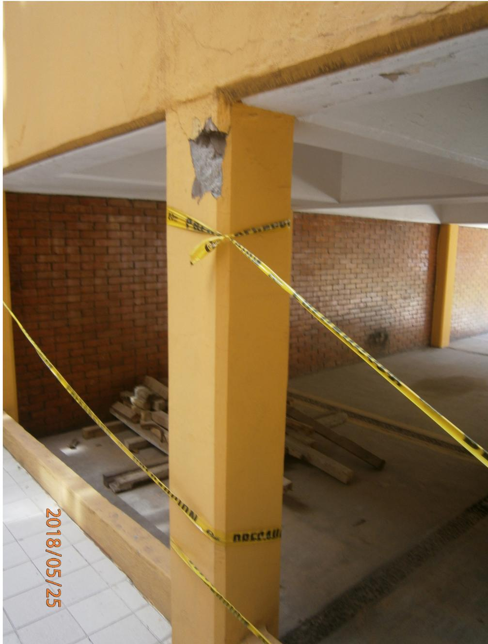
**Figura 2.19:** Daño grado II [25] en ciertas columnas de planta baja del edificio.
