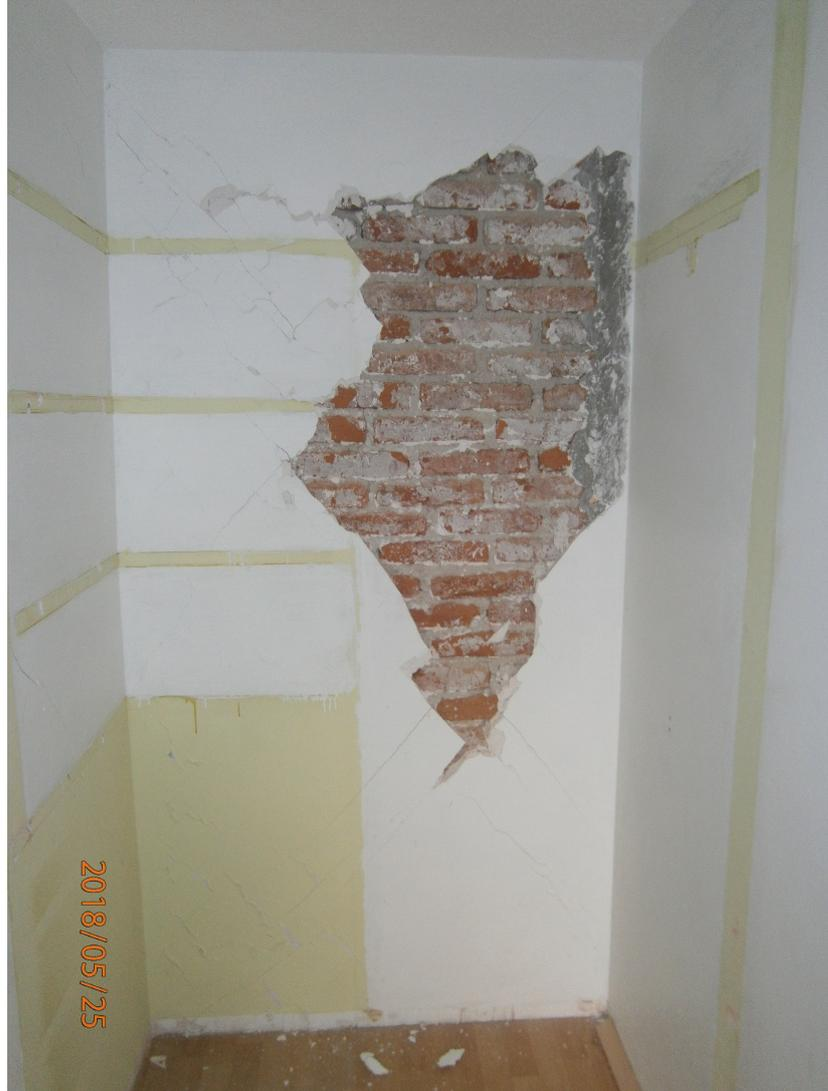
**Figura 2.21:** Desprendimiento de yeso, pintura y recubrimiento de los muros.
