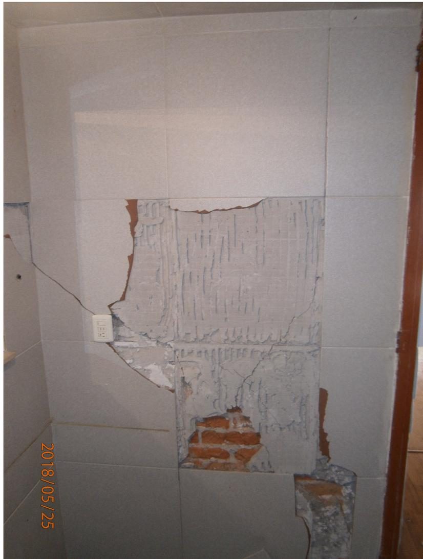
**Figura 2.20:** Azulejo desprendido por fisura diagonal por fuerza cortante en el baño del departamento.
