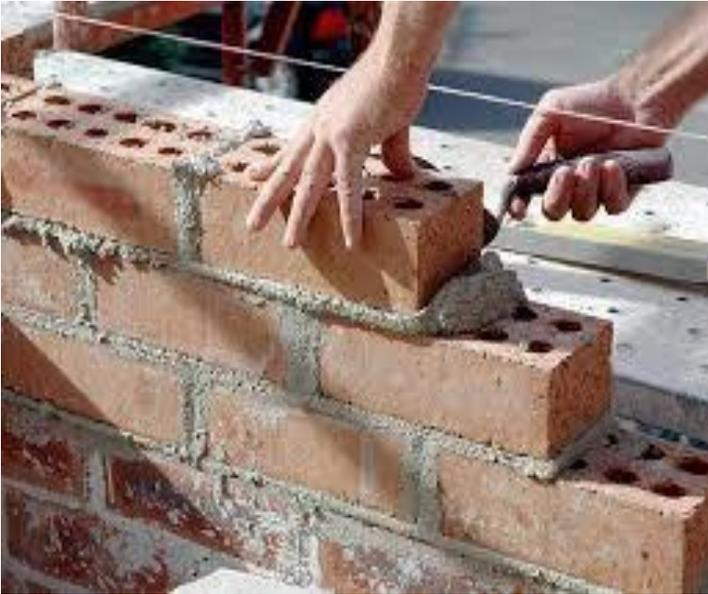
Foto 11, Junteo de Piezas Multiperforadas. Fuente: Propia
