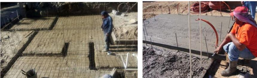
Foto 21, colocación de acero de refuerzo en la cimentación y vaciado de losa. Fuente: Propia
