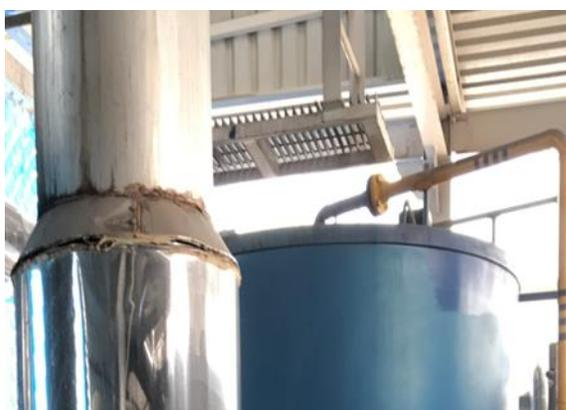
Figura 4.2 Desgaste en tubería
