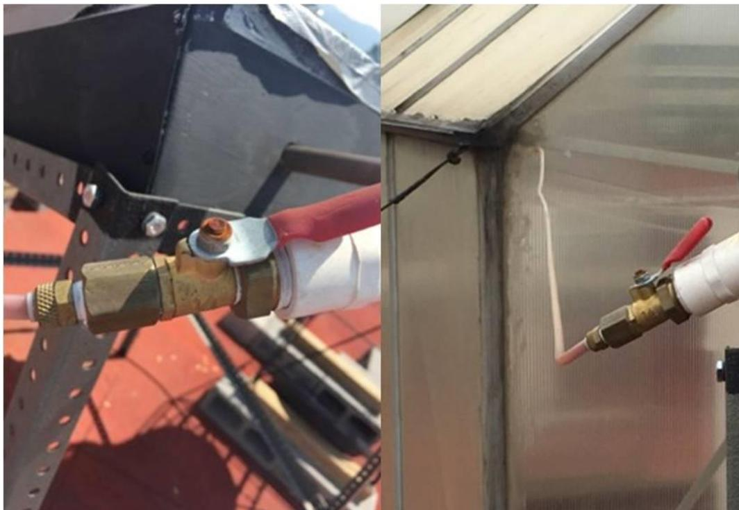
**Figura 3.13: Conexión cabezal ½" a válvula ¼" con llegada a caseta.**
