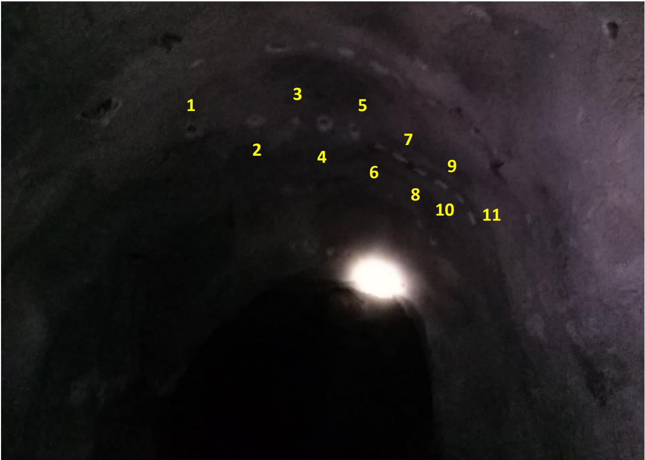
Figura 32. Sección de medio abanico ejecutada en campo, constandingo de 11 barrenos
