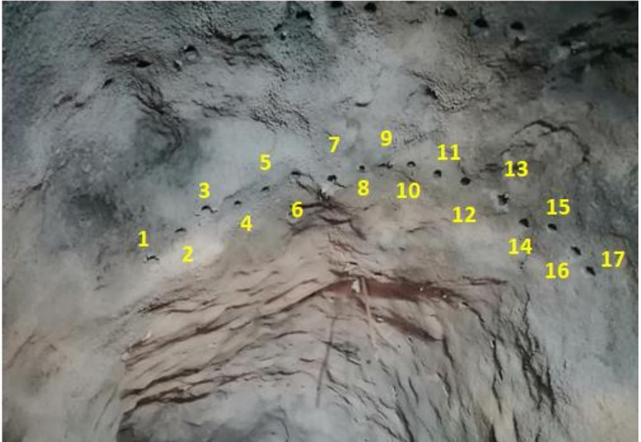
Figura 30. Sección de abanico completo ejecutada en campo, constando de 17 barrenos
