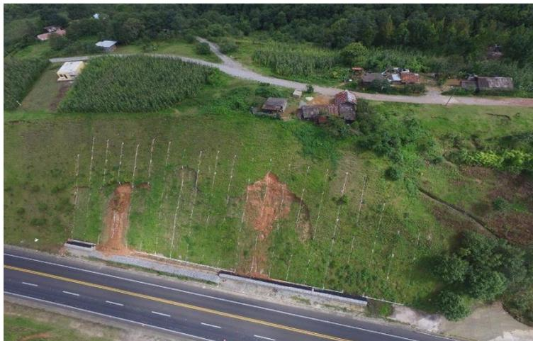
**Figura IV.2** Ejemplo de la falla de un talud debido a la falta de drenaje (Dominguez, 2018).
