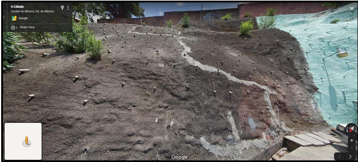
Figura I.4 Vista frontal del talud donde se observa el agrietamiento sobre la pendiente del talud.
