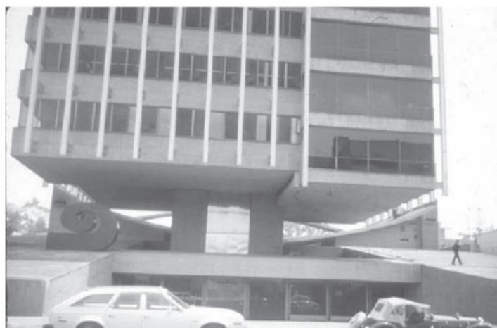
Figura 1.1 Edificios con piso flexible.
