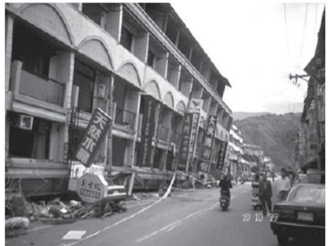
Figura 1.3 Estructuras que colapsaron debido a la presencia del primer piso blando.
