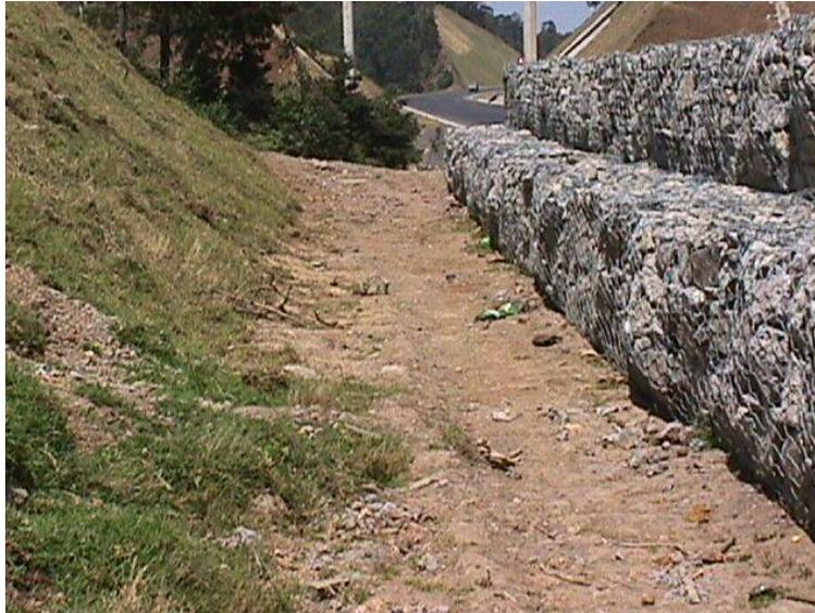
*Fotografía 40: Vista trasera de los muros gavión.*
