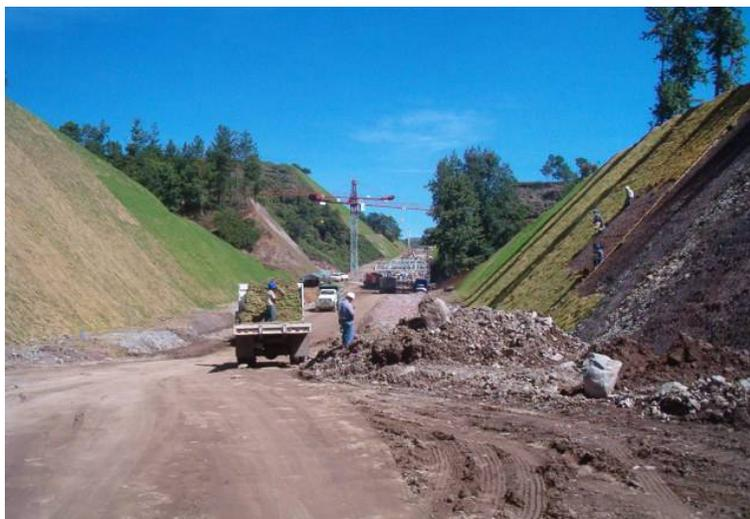
*Fotografía 36: Colocación de pasto en taludes*
