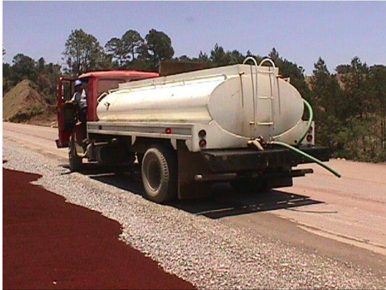
*Fotografía 18: Equipo utilizado (Pipas con agua)*
