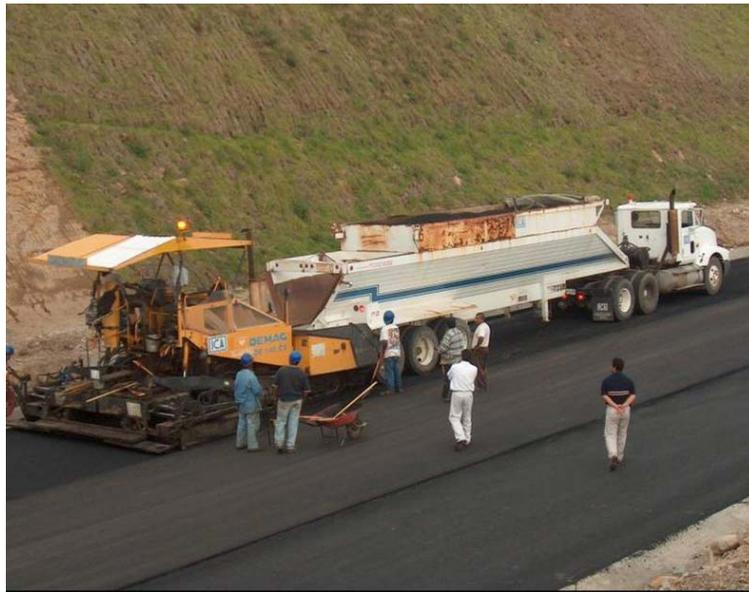
*Fotografía 56: Colocación de carpeta asfáltica*
