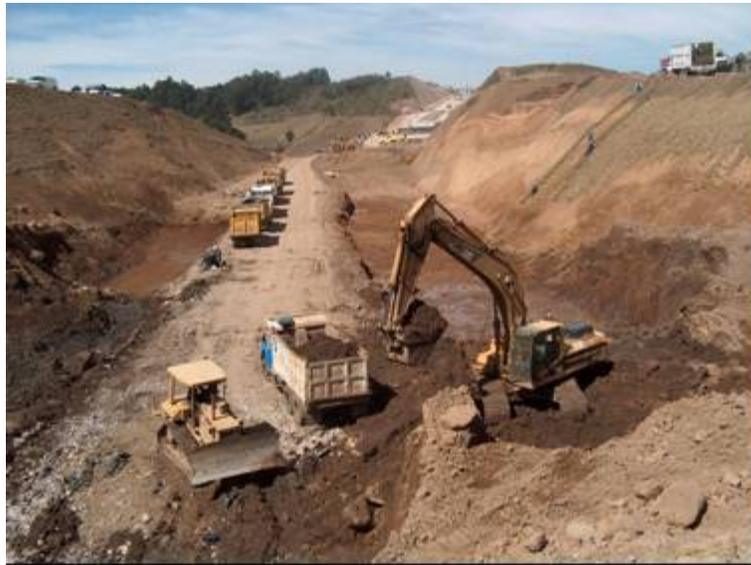
*Fotografía 11: Excavación para la formación de terraplenes.*
