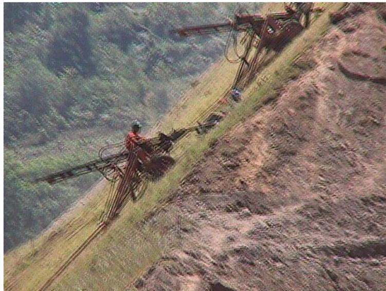
*Fotografía 68: Perforaciones para los drenes transversales de penetración.*
