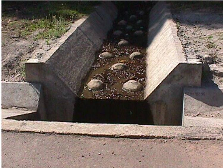
*Fotografía 70: Lavaderos de concreto hidráulico*
