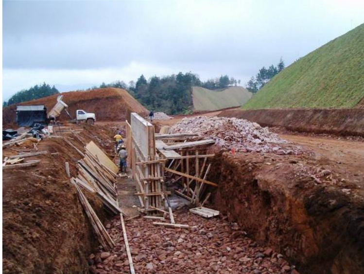
*Fotografía 41: Muros Alcancía de concreto armado*
