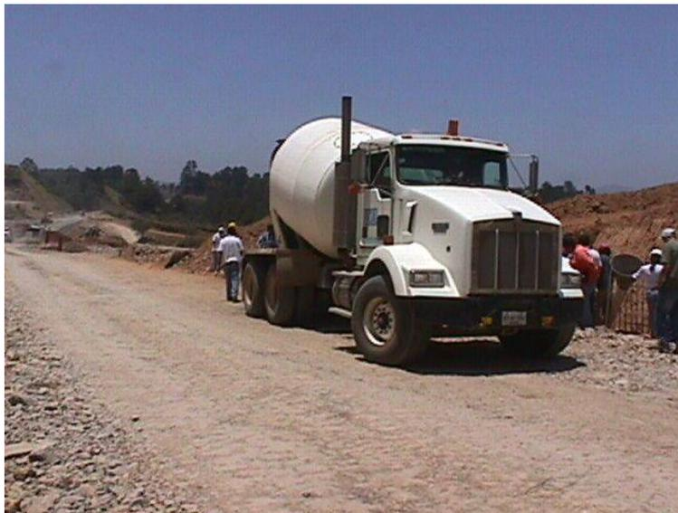
*Fotografía 64: Hoyas revoladoras para transportar concreto*
