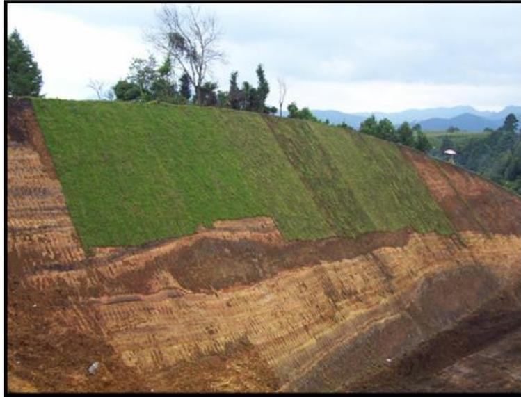
Fotografía 37: Revestimiento de taludes con pasto
