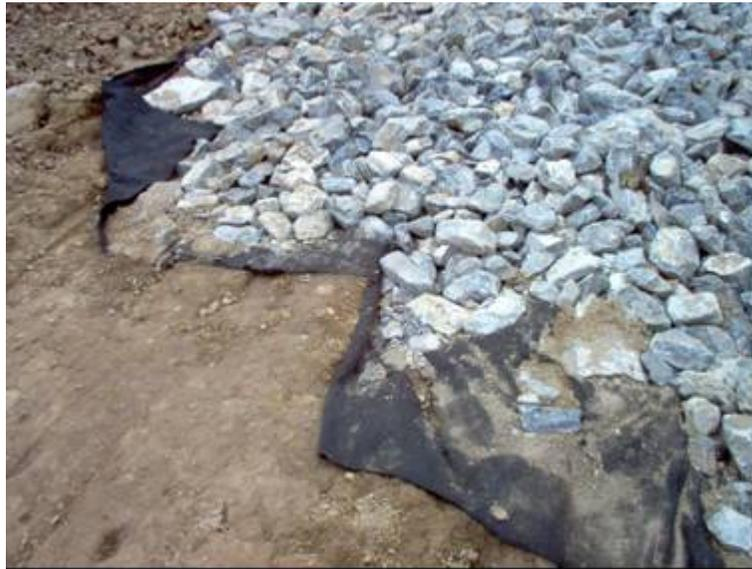
*Fotografía 43: Utilización de geotextil separador.*
