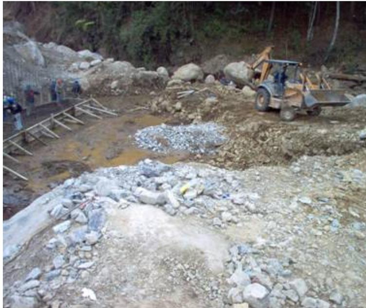
*Fotografía 59: Colocación del material con bandeos*
