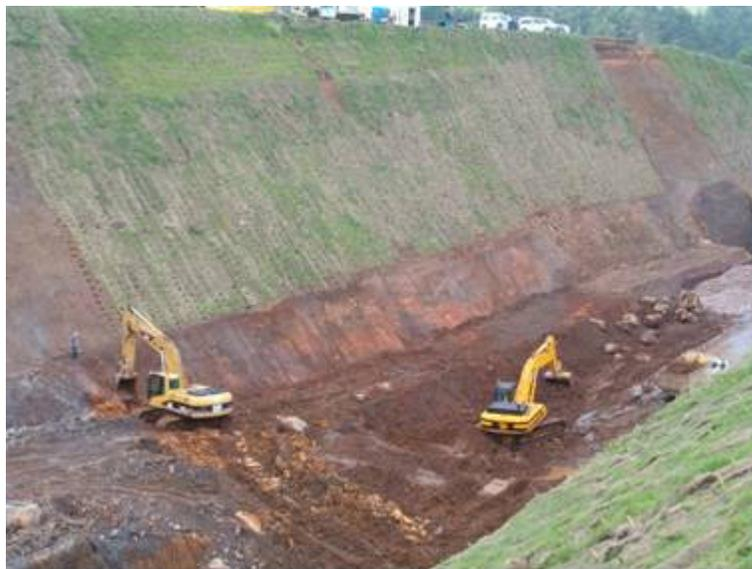
*Fotografía 48: Corte de material de desperdicio.*
