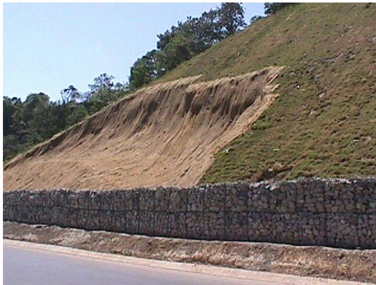
*Fotografía 39: Colocación de muros gavión.*
