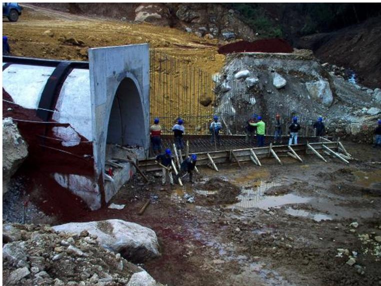
*Fotografía 61: Construcción de muros en bóvedas*
