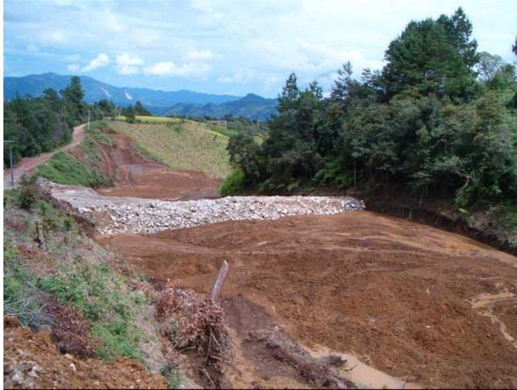
*Fotografía 49: Retención de material en los bancos de desperdicio*
