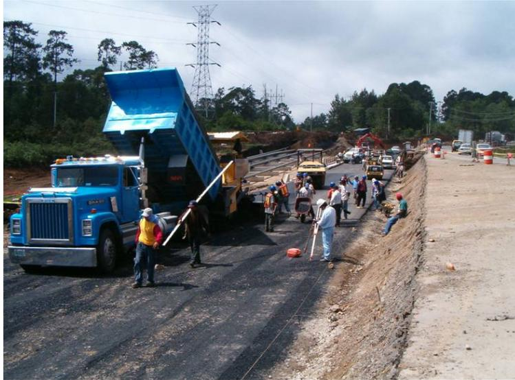
*Fotografía 13: Colocación de la carpeta asfáltica*
