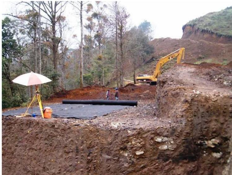
*Fotografía 44: Proceso de encapsulado con el geotextil.*
