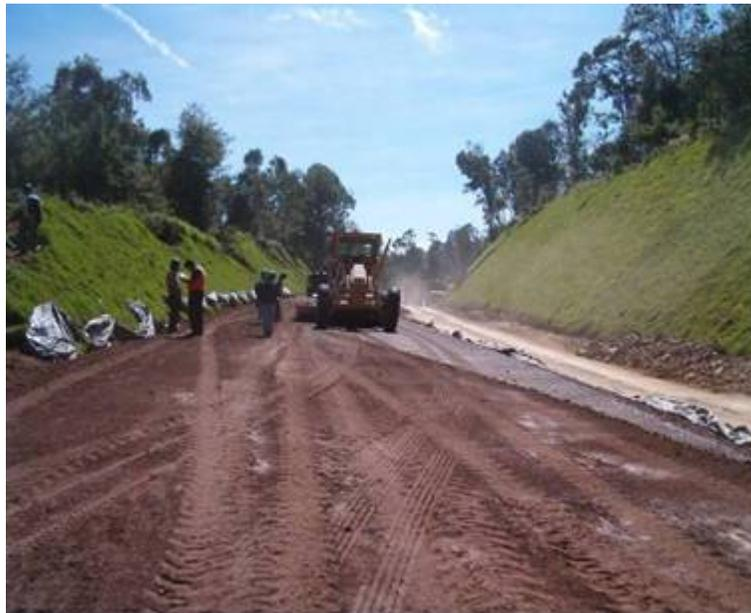
Fotografía 50: Formación de capa de base hidráulica.
