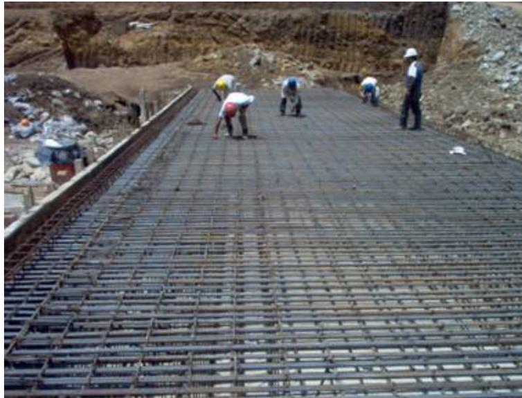
*Fotografía 60: Colocación de acero de refuerzo en bóvedas*
