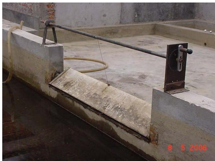
*Fig. 2.7 Compuerta tipo abatible.*
