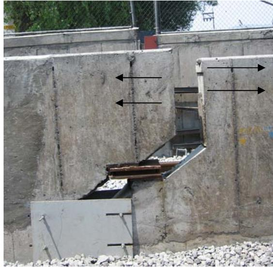
**Figura 3.10** Falla por separación del patín superior, junta expansiva (cadenamiento 22+250)
