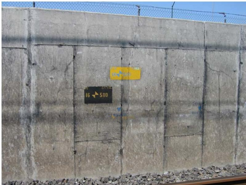
**Figura 5.6 se muestra el agrietamiento que presenta los muros laterales cadenamiento 16+580**
