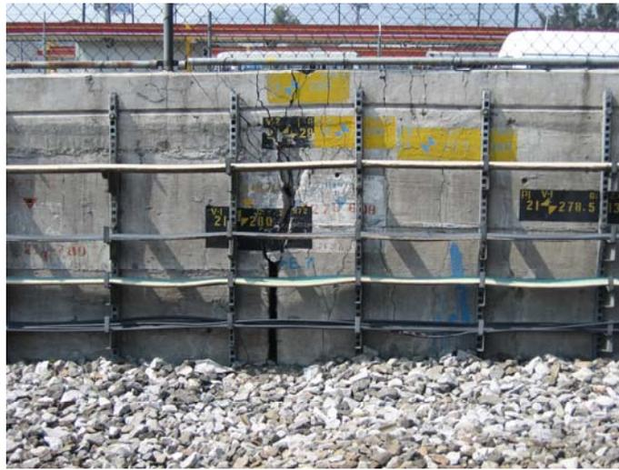
**Figura 5.9** Se muestra el aplastamiento del concreto, en los muros laterales, la grieta en la parte inferior evidencia la falla a tensión de la losa, cadenamiento 21+280
