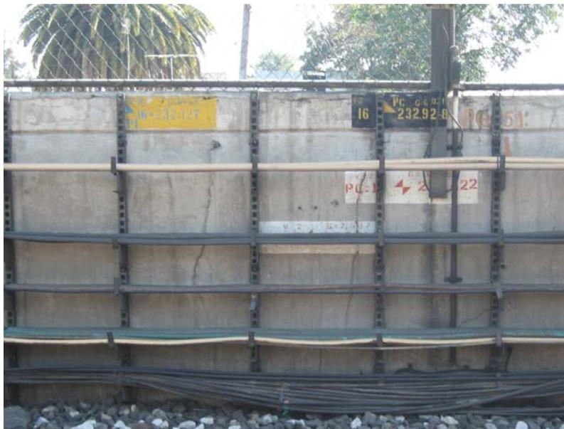
Figura 5.2 se muestra el agrietamiento, generado por la flexión, que presenta los muros laterales cadenamiento 16+232
