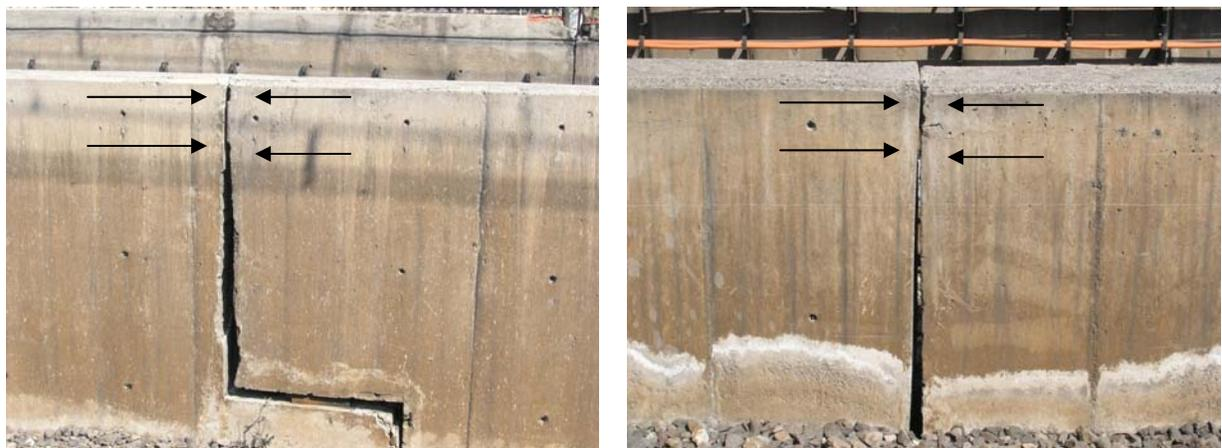
**Figura 3.8** Falla por compresión del patín superior, junta expansiva (foto izquierda, cadenamiento 18+680) y de construcción (foto derecha, cadenamiento 19+035)
