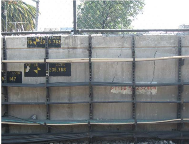
**Figura 5.3** se muestra el agrietamiento, generado por la flexión, que presenta los muros laterales cadenamiento 16+235
