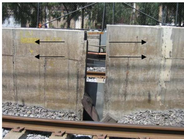
**Figura 3.13 Falla a tensión de la losa (cadenamiento 17+495)**
