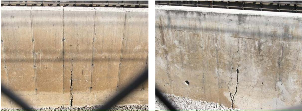
**Figura 3.19** Falla por compresión en los muros del cajón del metro, (cadenamiento 17+143)
