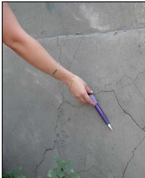
**Figura 5.4** se muestra el agrietamiento, generado por la flexión, que presenta los muros laterales cadenamiento 16+284
