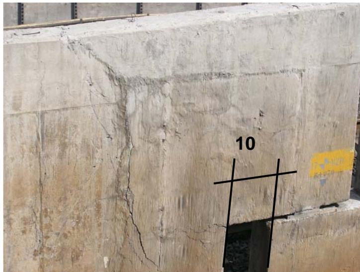
**Figura 3.7 Junta de expansión (cadenamiento 17+020)**
