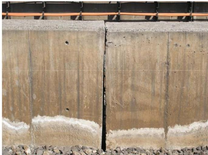
Figura 3.5 Junta de construcción (cadenamiento 19+035)
