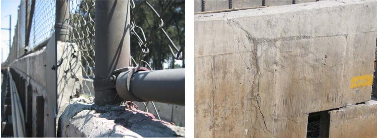
**Figura 3.14** Falla por desplazamientos verticales
