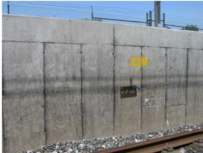
**Figura 5.7 se muestra el agrietamiento que presenta los muros laterales cadenamiento 16+620**
