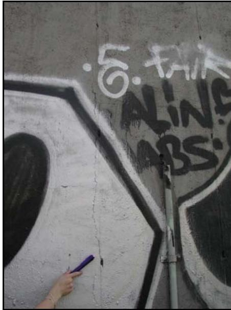
**Figura 5.5 se muestra el agrietamiento que presenta los muros laterales cadenamiento 16+556**
