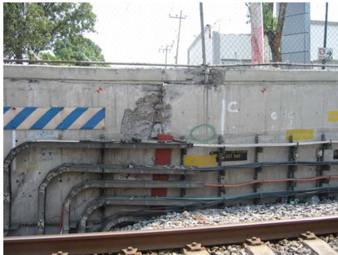
**Figura 5.10** Se muestra el agrietamiento que presenta los muros laterales cadenamiento 21+335
