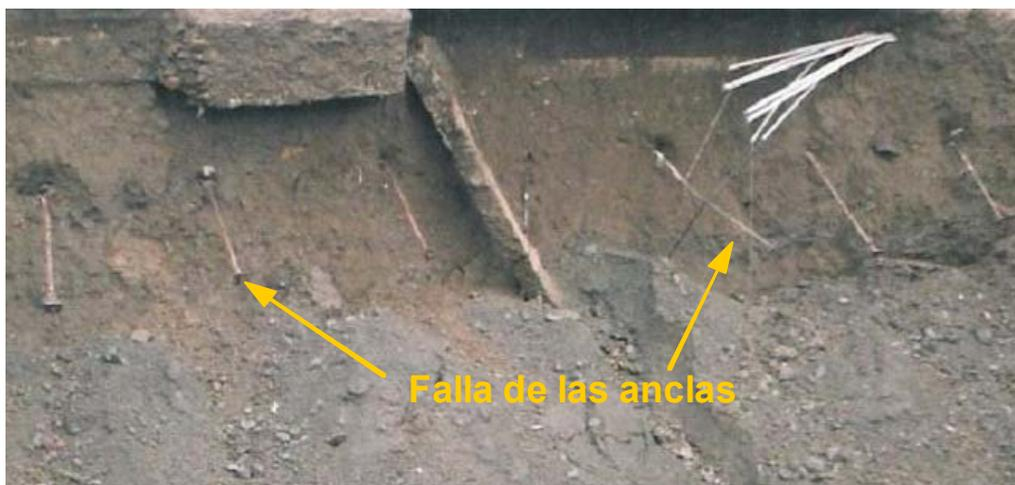
**Figura 9.7** Falla del anclaje en un corte por defectos en la inyección
