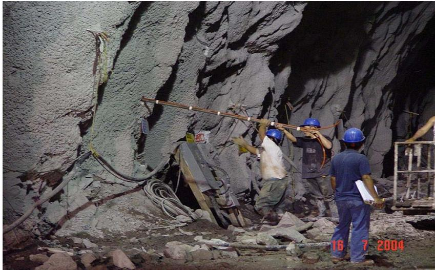
Figura 9.1 Colocación de anclas en las paredes de un túnel.
