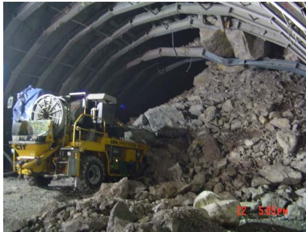
Figura 8.1 Inestabilidad de una excavación subterránea
