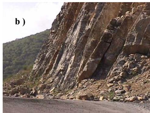
**Figura 2.7** a) Masa rocosa masiva con bloques muy grandes; b) Masa rocosa tabular.
