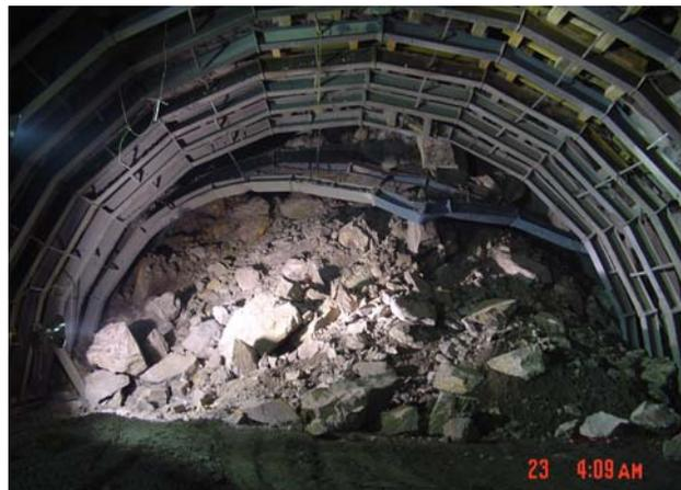
**Figura 9.6** Inestabilidad en el frente de una excavación subterránea
