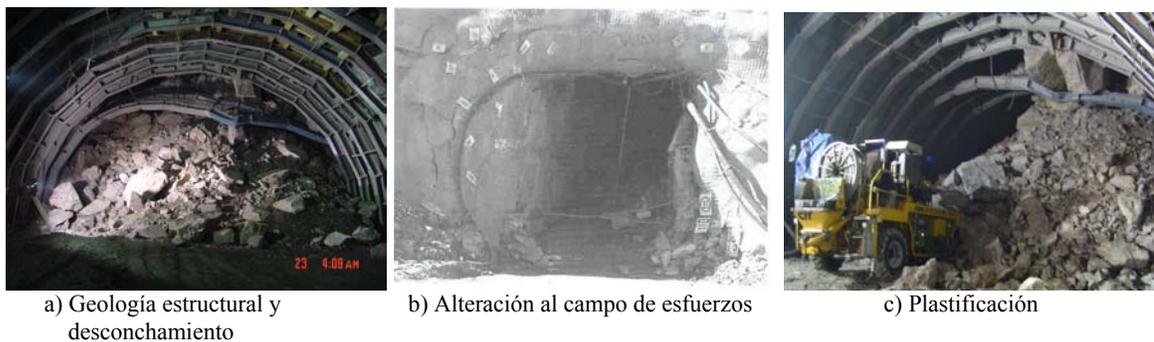
**Figura 1.1** Algunos casos de fallas en excavaciones subterráneas
