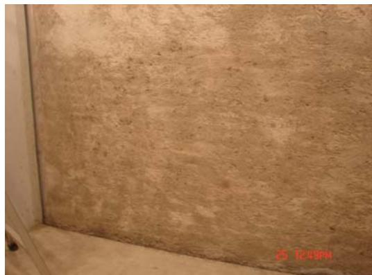
Foto 3.2. Muro construido para la caracterización para generar condiciones de aislamiento máximo
