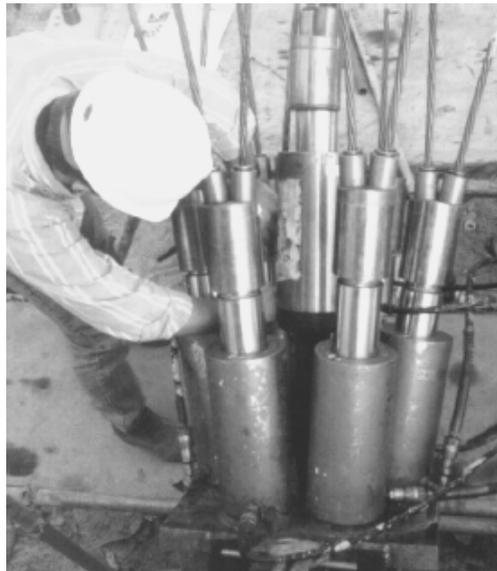
**Fig. 10.7** Tensado de varios torones al mismo tiempo con el uso sincronizados de siete gatos hidráulicos
