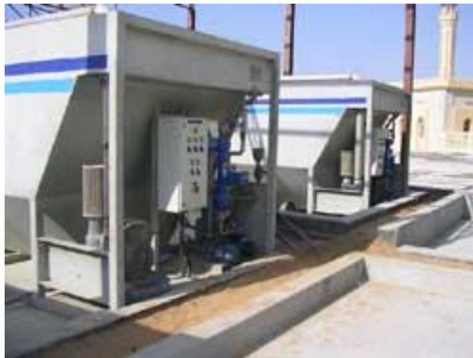
**Figura 22.** Planta paquete EEC de D.A.S.
