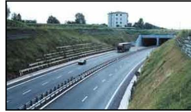
A lo largo de estas capas el agua podía ascender por capilaridad, disminuyendo la estabilidad y provocando la separación superficial de tierra de 200mm de profundidad. Se usaron dos técnicas para consolidar el talud: Geomantas, como de describió en la Sección anterior Tipo 4, y la construcción de un muro pre-fabricado relleno con suelo granular para un apropiado drenaje.
