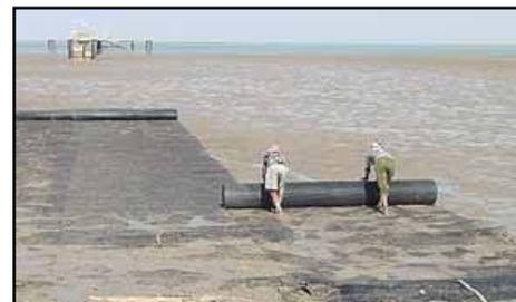
tuvieran la capacidad de confinar el agregado y distribuir la carga. El proyecto se dividió en cuatro áreas separadas: el acceso principal del camino con 9 Km. de largo; una isla artificial que sería utilizada para la construcción de la estación militar; un acceso de 550m conectando la estación con un muelle; y la instalación de gaviones en los hombros de los taludes, en las zonas sujetas a corrientes de mareas.
