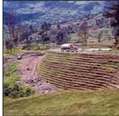
FIG. 2.21 TALUD CON PENDIENTE MUY PRONUNCIADA REFORZADO CON GEOMALLAS MONO-ORIENTADAS
