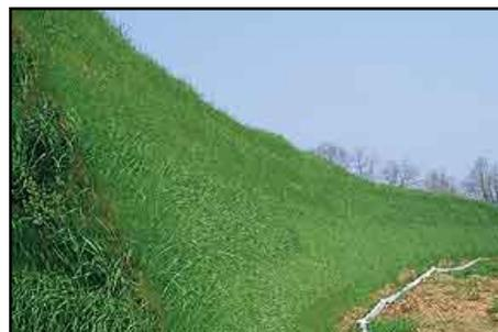
FIG. 3.32 TALUD CON REFUERZO EN EL CÉSPED PARA MITIGAR LA EROSIÓN
