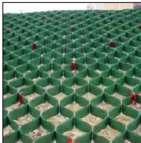
FIG. 3.39 PANELES DE GEOCELDAS CON ANCLAS ROJAS
