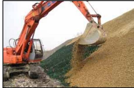
**FIG. 3.40 RELLENO CON TIERRA VEGETAL SOBRE LAS GEOCELAS**
