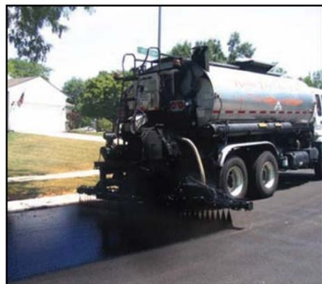
**FIG. 3.9 PETROLIZADORAS HACIANDO RIEGO DE EMULSIÓN TIPO AC**
