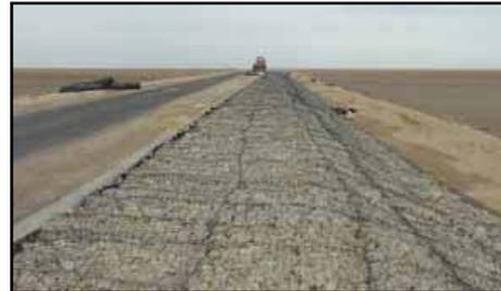
formaría la instalación militar costera se construyó usando también 2 capas de geomalla tipo 440 y una tipo 220. El diseño del acceso de 550m lo realizó el proveedor y fabricante de Geosintéticos. La altura del acceso que conectaría la isla artificial con el muelle variaba de 1.7 a 3.0m de altura.
