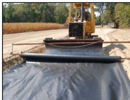
FIG. 3.27 COLOCACIÓN DEL ROLLO DE
