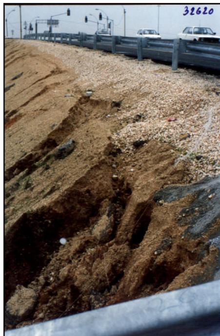
**FIG. 3.31 TERRAPLÉN CARRETERO DESPUÉS DE LLUVIA. MARCAS DE EROSIÓN FORMADAS POR EL ESCURRIMIENTO DE AGUA SOBRE EL TALUD**
