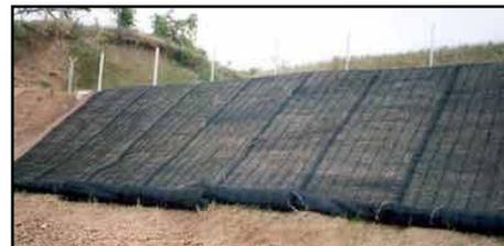
**FIG. 3.36 GEOMANTAS COLOCADAS LISTAS PARA LA HIDROSIEMBRA**
