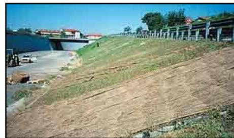
Las condiciones existentes, no permitieron garantizar la consolidación del suelo, fueron cortadas y reemplazadas con una mezcla de céspedes y plantas de raíz profunda después de la nivelación del talud. Una biomanta antierosión (malla 20 x 20mm; fijo con 2 pijas/m<sup>2</sup>) fue colocada con el fin de evitar que grandes volúmenes de tierra resbalaran al camino, además de ayudar al césped a tomar raíz. La biomanta se fijó a 1m más allá de la cresta.
