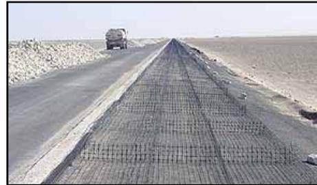
El diseño permitiría asentamientos durante la fase de construcción para asegurar un camino estable en la vida útil de la obra. Debido a la baja capacidad de carga en el suelo de cimentación, el diseño no permitía la utilización de geotextiles no tejidos o geomallas tejidas.
