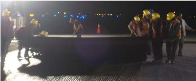
**FIG. RA.3 COLOCADO DE GEOTEXTIL A MANO POR 4 OBREROS EN LA PISTA 05R-23L DEL AEROPUERTO INTERNACIONAL DE LA CIUDAD DE MÉXICO, OCTUBRE 2008**
