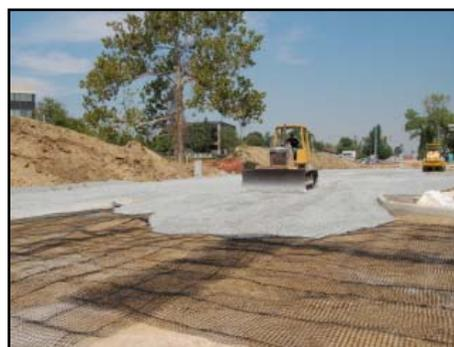
**FIG. 3.29 ESPARCIMIENTO DEL MATERIAL GRANULAR SOBRE LA GEOMALLA**
