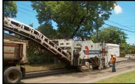
**FIG. 3.7 CORTE DE ASFALTO. FRESADORA CON BANDA TRASPORTADORA**
