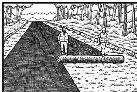
**FIG. 3.3 DESENROLLO DE GEOTEXTIL SOBRE SUPERFICIE PLANA**
