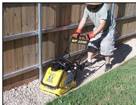
**FIG. 3.2 COMPACTADO DE AGREGADO CON COMPACTADOR VIBRATORIO**
