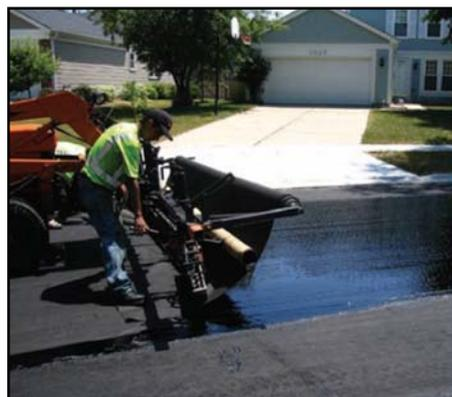
**FIG. 3.10 COLOCADO DE GEOTEXTIL CON EQUIPO ESPECIALIZADO**
