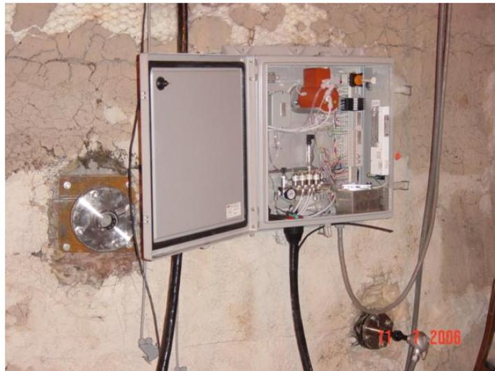
Figura 3.2. Instalación del transmisor de temperatura
