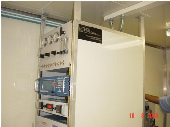
Figura 3.4. Gabinetes del sistema de adquisición de datos
