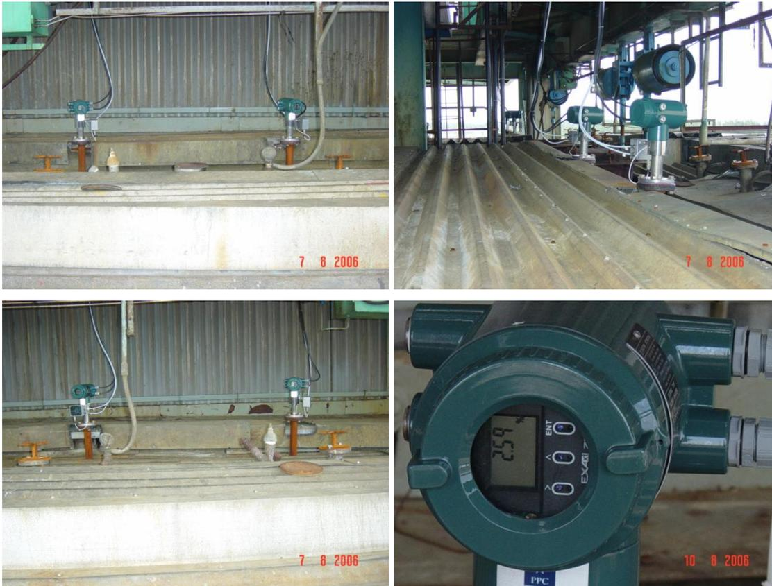
Figura 3.12. Analizadores de oxígeno en ductos
