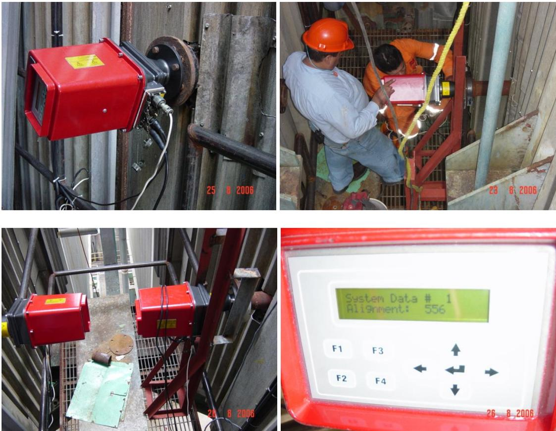
Figura 3.13. Instalación de los analizadores de CO
