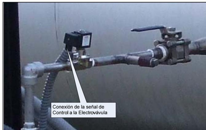
Figura 4.17. Conexión de la señal de control de la electroválvula.
