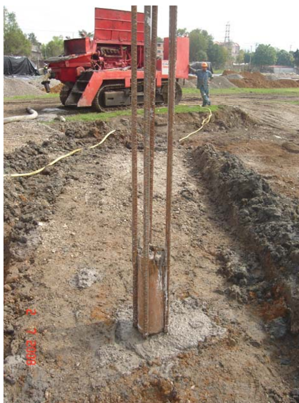
Fig. 8.40 Limpieza, pila terminada
