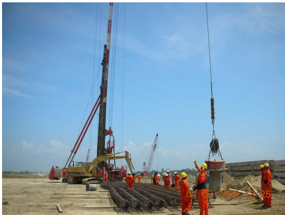
Fig. 8.23 Colocación del vibrador, preparación del acero de refuerzo para recibir el vibrador
