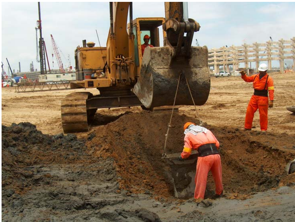
Fig. 8.29 Colocación del brocal, localización de la pila
