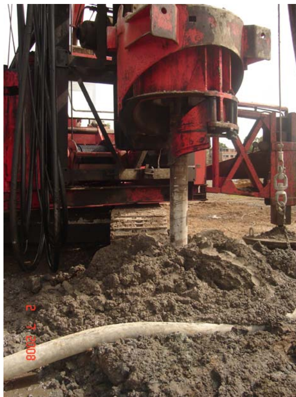
Fig. 8.17 Perforación, introducción completa del a helicoidal, termino de penetración
