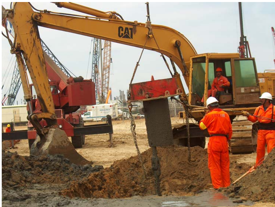
Fig. 8.39 Limpieza, retiro del vibrador
