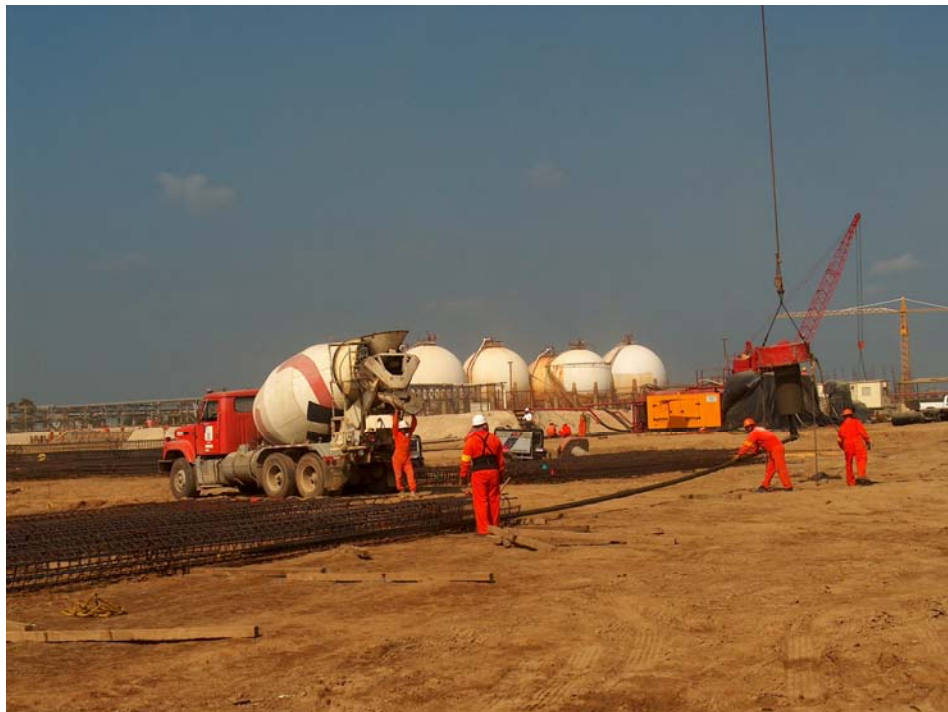
Fig. 8.23 Colocación del vibrador, preparación del acero de refuerzo para recibir el vibrador
