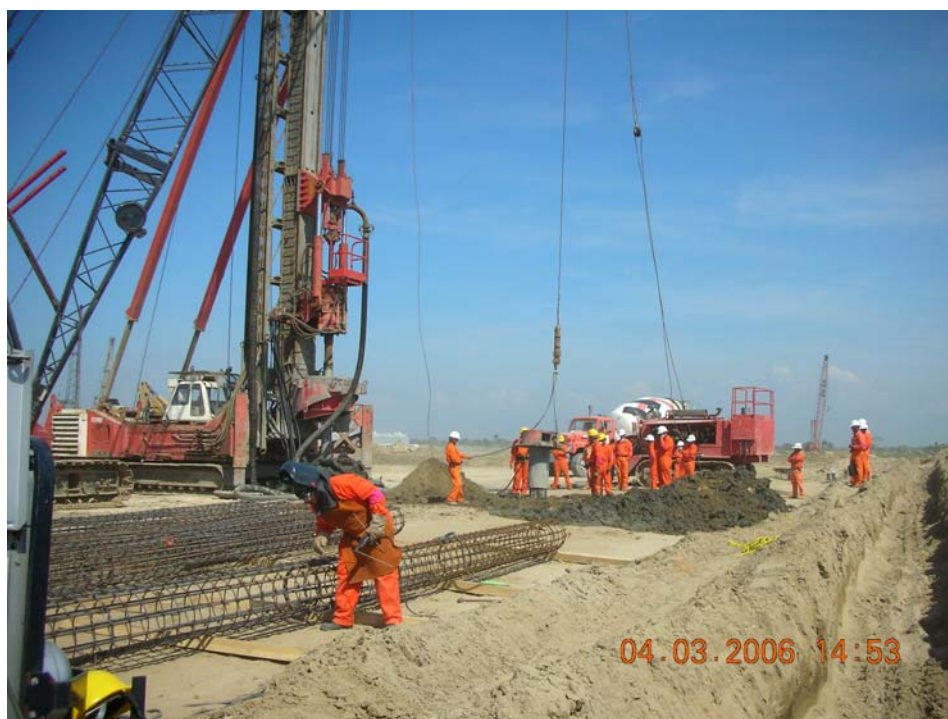
Fig. 8.35 Introducción del acero, asentamiento del acero a la profundidad requerida
