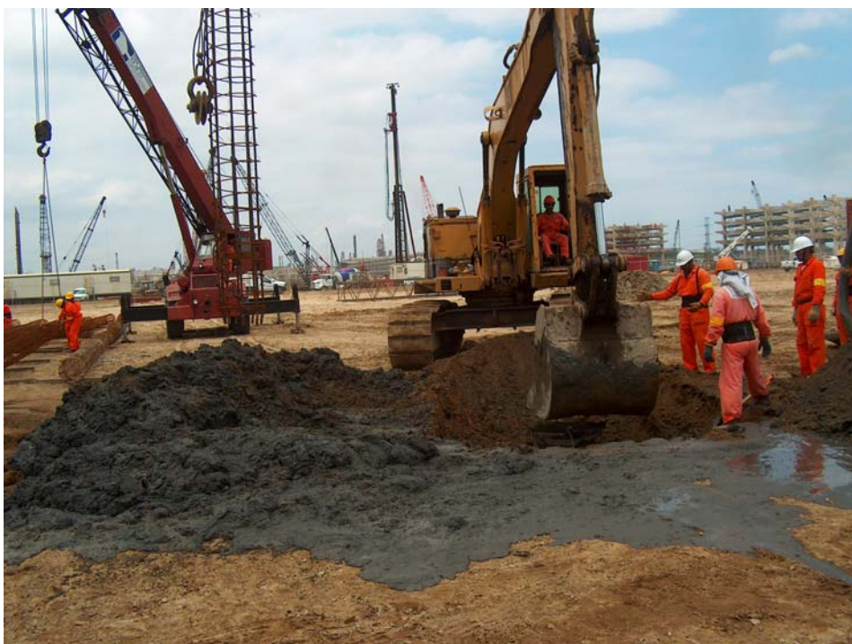
Fig. 8.29 Colocación del brocal, localización de la pila
