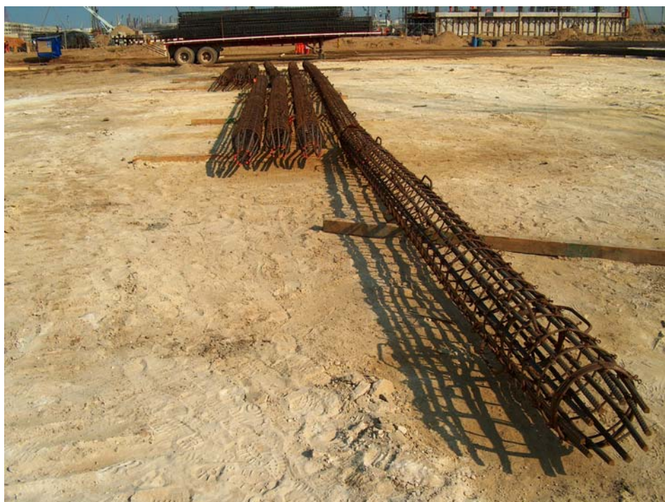
Fig. 8.14 Habilitado del acero de refuerzo, producto terminado
