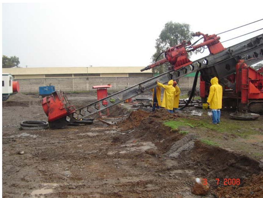
Fig. 8.3 Trabajos preliminares, montaje del bote limpiador
