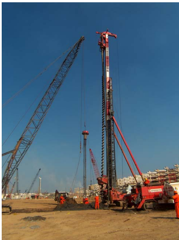
Fig. 8.33 Introducción del acero, proceso
