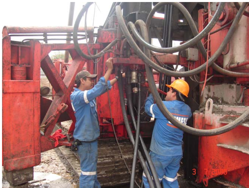
Fig. 8.5 Trabajos preliminares, instalación de sensores y mangueras
