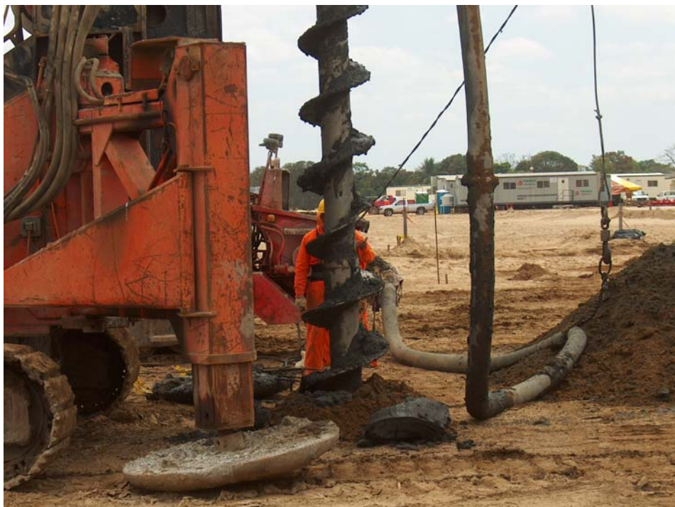
Fig. 8.15 Perforación, inicio del proceso
