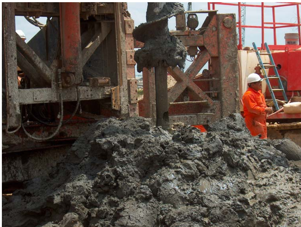
Fig. 8.21 Inyección de concreto, terminación de colado
