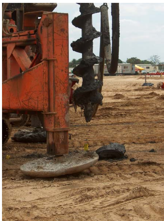
Fig. 8.8 Alineamiento y nivelación, posicionamiento y nivelación de la maquinaria
