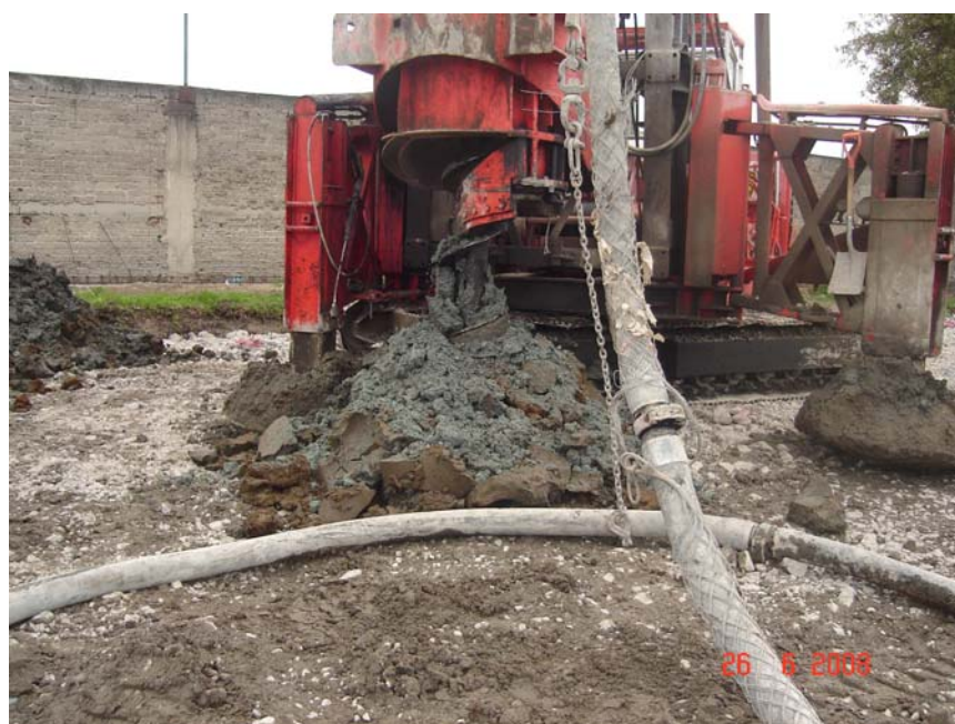
Fig. 8.18 Inyección de concreto, inicio de inyección
