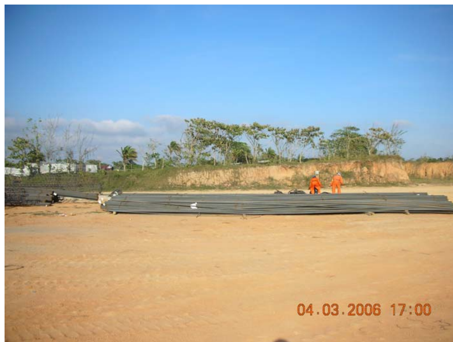
Fig. 8.9 Habilitado del acero de refuerzo, almacenaje
