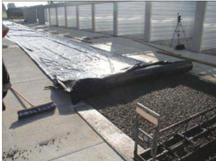
Figura 4.10 Material de polietileno utilizado para cubrir la superficie expuesta del concreto permeable (Tennis et al., 2004).
