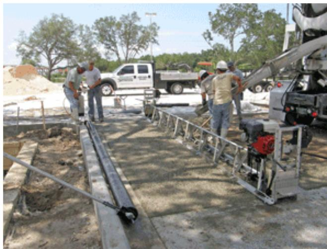
Figura 4.6 Enrasado del concreto permeable mediante el uso de una enrasadora vibratoria de marco con sección tipo “A” ([www.perviousconcrete.com](http://www.perviousconcrete.com)).
