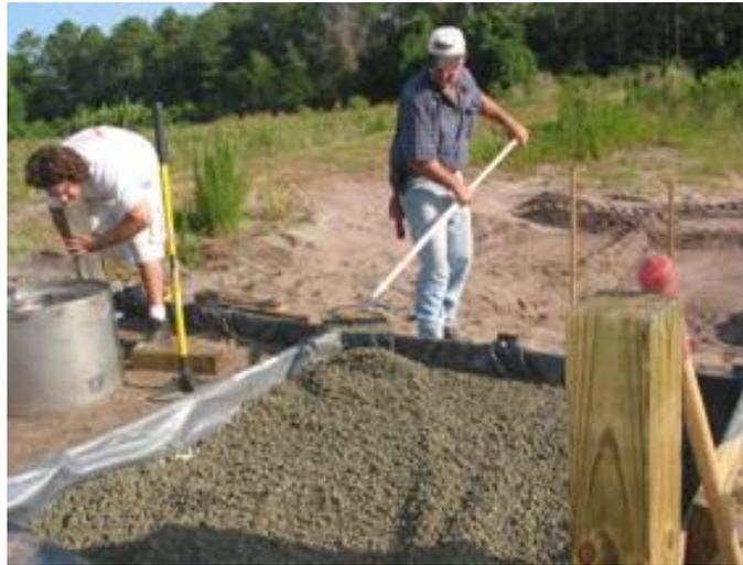
Figura 4.3 Rastrillado del concreto permeable a una elevación aproximada.
