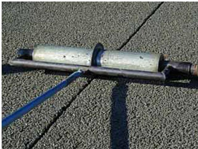
Figura 4.9 Construcción de una junta mediante la adaptación de una hoja en el rodillo de compactación ([http://www.ctre.iastate.edu/Research/project\\_photos/pervious\\_joint.jpg](http://www.ctre.iastate.edu/Research/project_photos/pervious_joint.jpg)).
