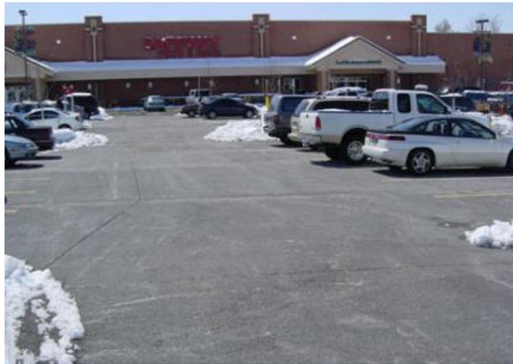
b. Superficie con concreto permeable
