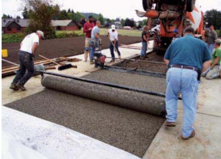
Figura 4.7 Compactación del concreto permeable mediante el uso de un rodillo (Tennis et al., 2004).
