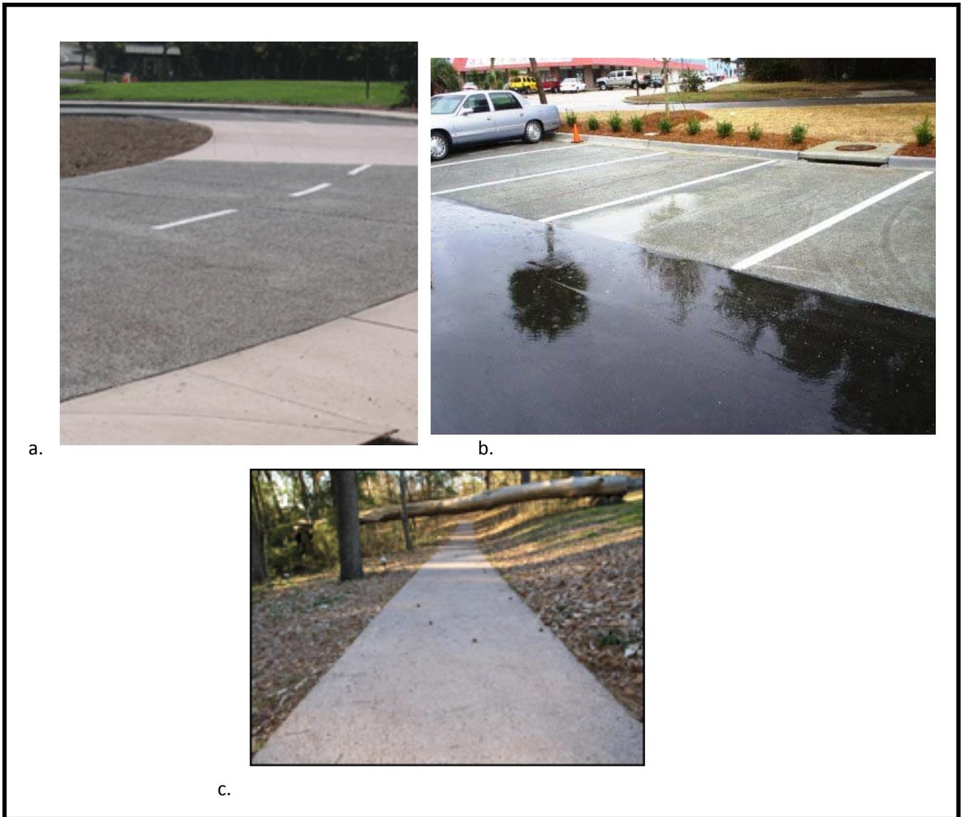
Figura 1.2 Principales usos del concreto permeable: a. Vialidades con tráfico ligero(<http://www.vma-engineers.com/>), b. Estacionamientos(<http://www.perviousconcrete.info/pictures.htm>), c. Andadores ([http://www.alconcrete.org/concrete\\_products.aspx](http://www.alconcrete.org/concrete_products.aspx))
