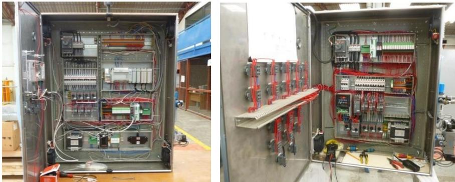
Se fabrican tableros de diferentes tamaños y capacidades de acuerdo a la cantidad de máquinas que se desean controlar y a la función que realizan. Un ingeniero de diseño mecatrónico programa el PLC que es el cerebro del tablero y que controlara las señales y la distribución de la energía eléctrica de los motores, electroválvulas, sensores y demás componentes de las máquinas.
