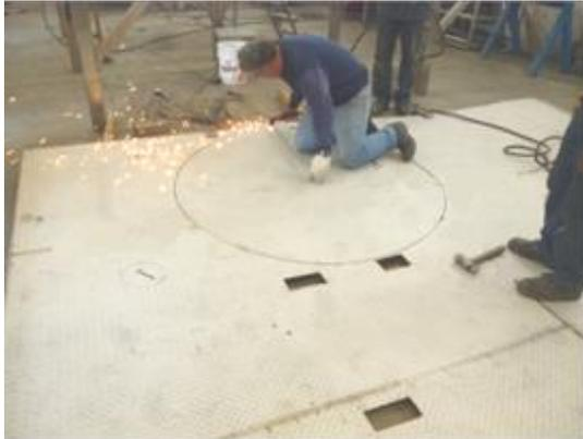
Figura 3.5.-Corte con plasma de placa circular de acero inoxidable.
